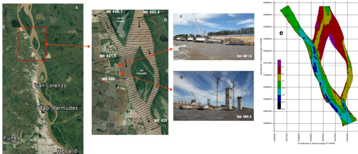
Figura 1. a y b) Tramo del río Paraná en estudio, imagen Google Earth ©; c y d) Ubicación de las estructuras portuarias en el cauce; e) Modelo digital batimétrico del cauce (m) IGN.
