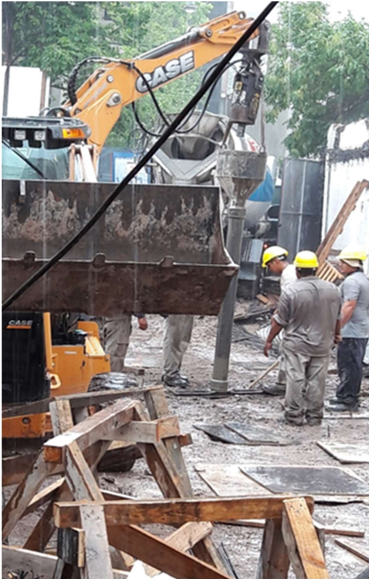
Figura 15. Fotografía tomada en la Obra 1. Zonas de circulación ocupadas por restos de maderas. Falta de orden y limpieza dentro de la obra. Fuente: Elaboración propia.
