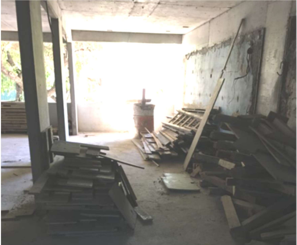
Figura 24. Fotografía tomada en la Obra 4. Separación de madera por tipo y uso. Fuente: Elaboración propia.
