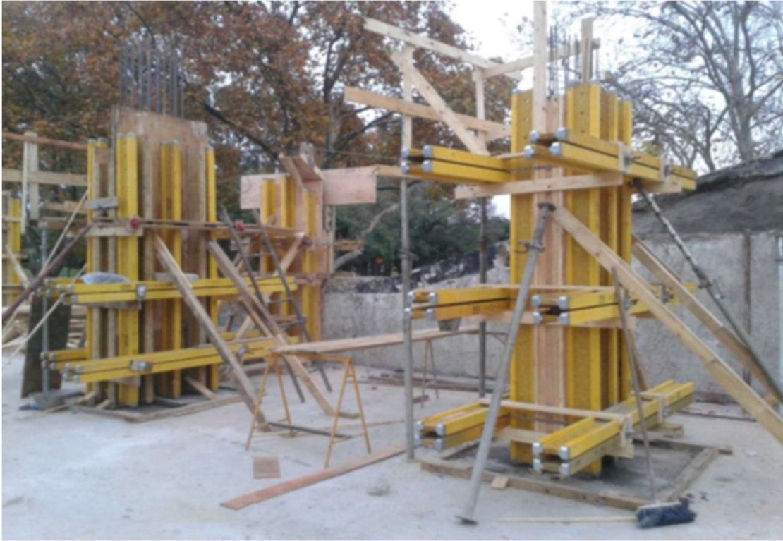
Figura 20. Fotografía tomada en la Obra 3. Empleo de encofrados reutilizables (vigas Peri y puntales telescópicos). Fuente: Elaboración propia.
