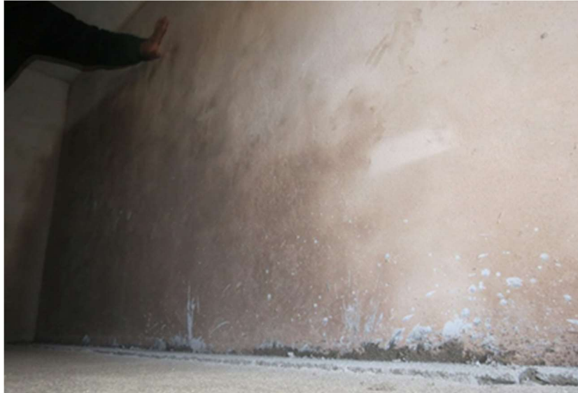
Figura 6. Revoque fino de edificio construido en el barrio Nueva Córdoba (Córdoba capital), compuesto por eco-árido fino 100% reciclado de “La Escombrera”. Fuente: Página en red social Facebook de La Escombrera. Fotografía publicada el 2 de julio de 2014.
