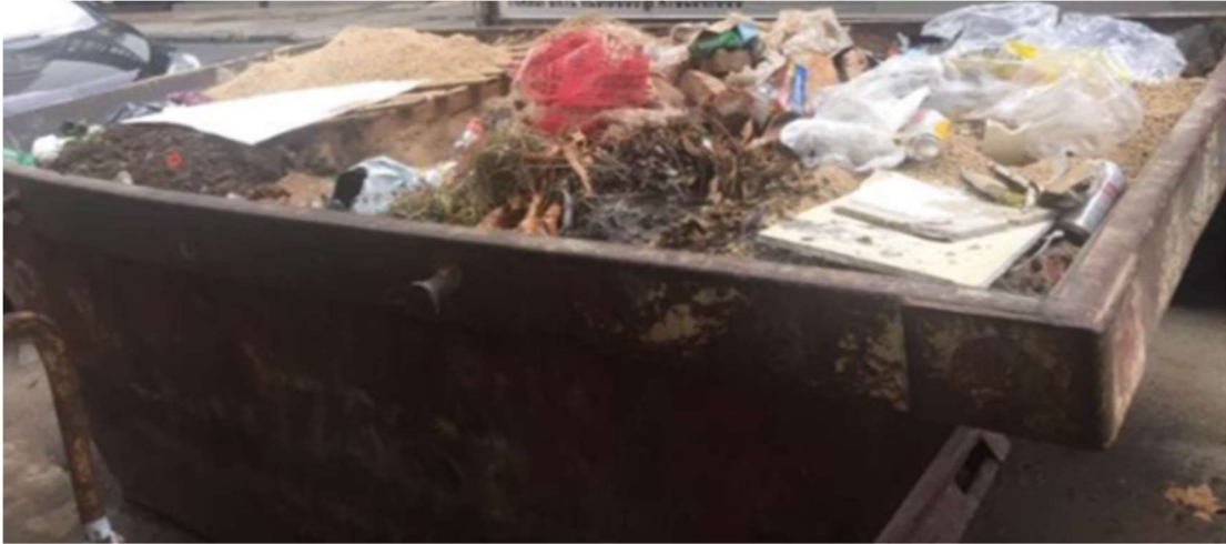
Figura 23. Fotografía tomada en la Obra 4. Disposición intermedia en contenedores sin clasificación ni separación por tipo. En el volquete se observan restos orgánicos, arena, tierra, plástico, papel, madera y vidrio depositados juntos. Fuente: Elaboración propia.
