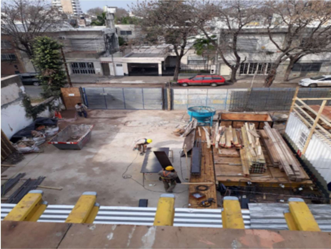
Figura 22. Fotografía tomada en la Obra 3. Zonas de circulación libres de restos, materiales acopiados por tipo y materiales descartados separados en bolsas. Fuente: Elaboración propia.
