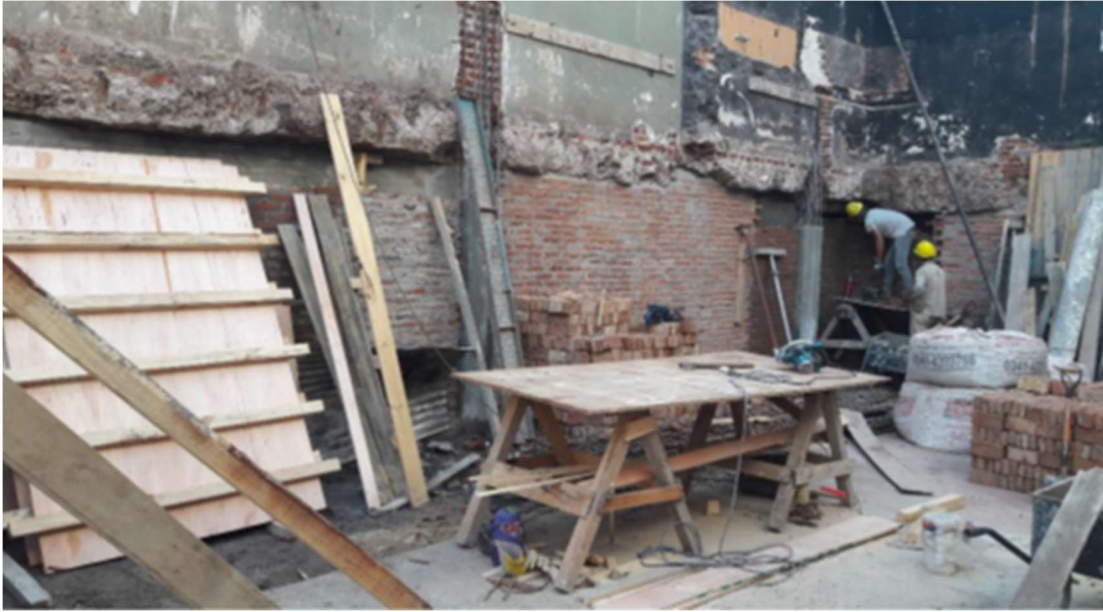
Figura 20. Fotografía tomada en la Obra 2. Materiales ordenados por tipo. Área de trabajo ordenada. Obreros empleando equipos de protección personal (guantes) para la manipulación de herramientas de trabajo y materiales. Fuente: Elaboración propia.
