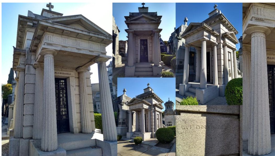
Imagen 19: Obra de Luis Fontana. Calle 5 entre 6 y 4.
