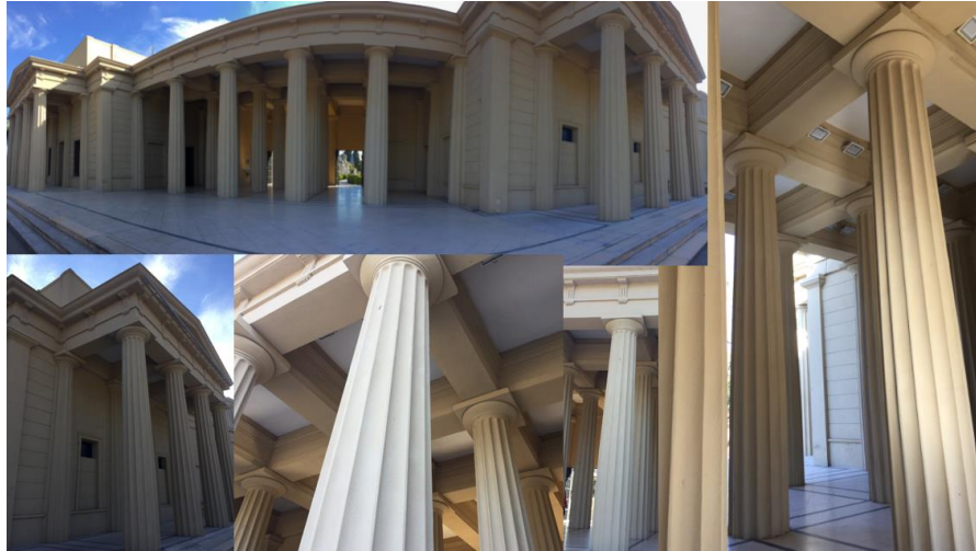
Imagen 02: Pórtico de entrada de orden dórico.
