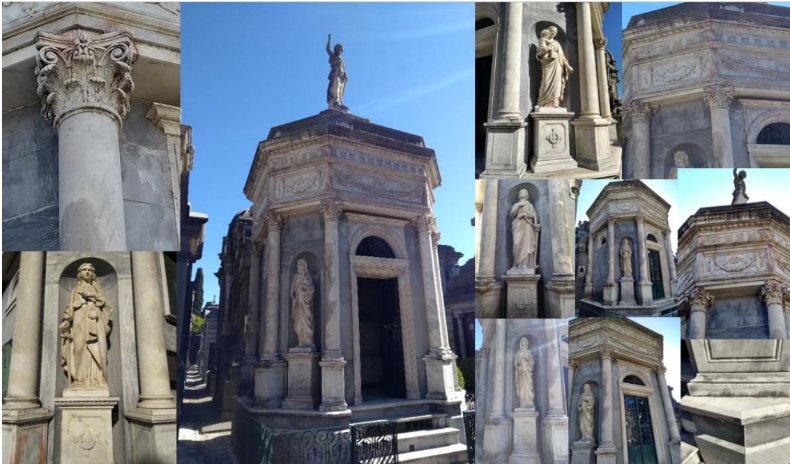
Imagen 14: Arquitecto, D. Ricca. Calle 6 intersección 3.
