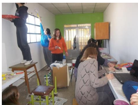
Imagen 8. Acondicionamiento lugar donde funciona CREAS Cooperativa Escolar
