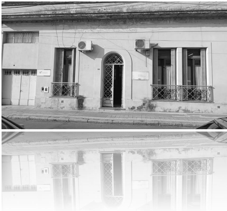
Fachada del inmueble donde funcionan actualmente las oficinas de la DGPL en Paraná
