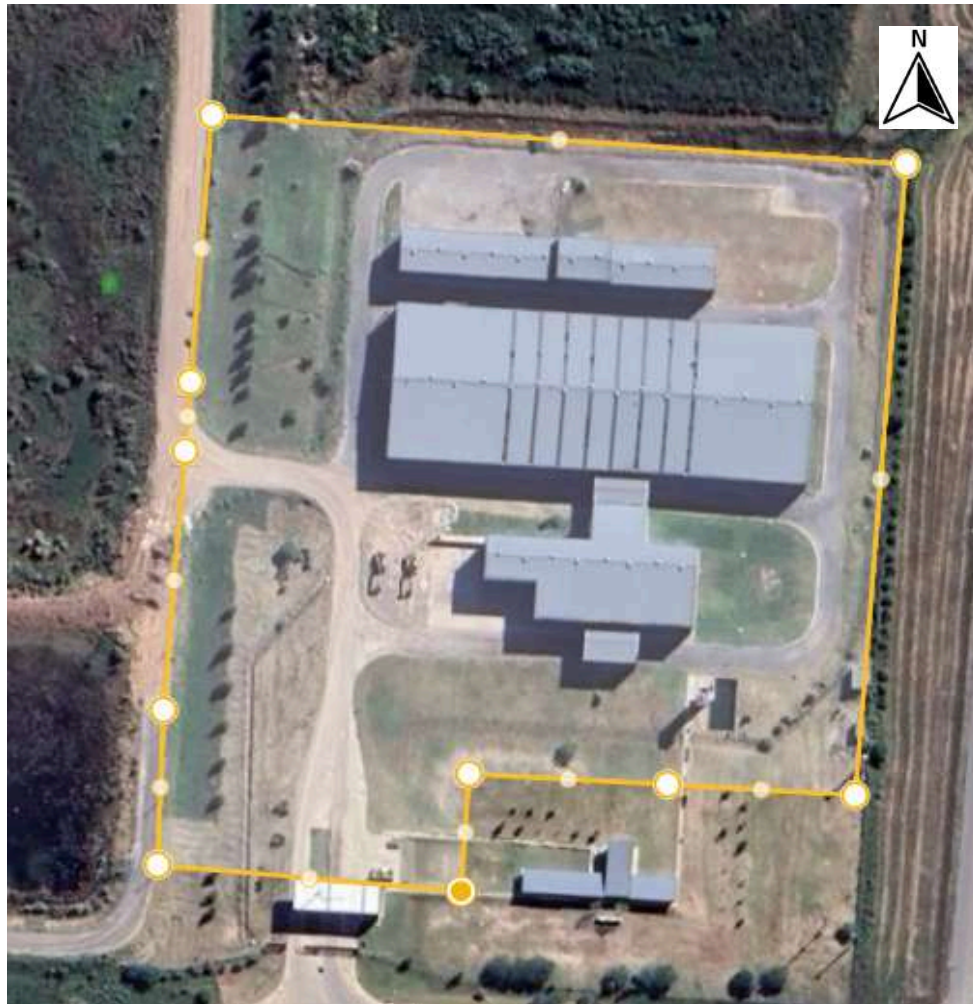
Imágen 12: Cuenca de aporte de alcantarillas sobre cuneta existente. Fuente: Google Earth.
