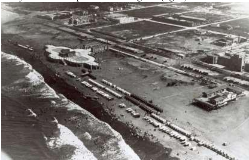
Fig. 2 Vista aérea, Rambla Municipal, rambla de madera y hotel Necochea
