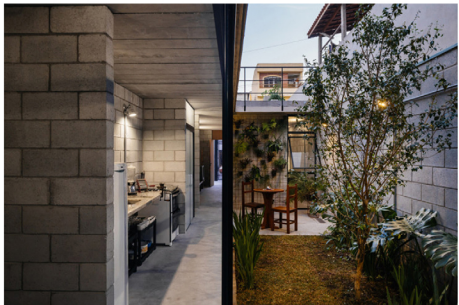
MATERIALIDAD. BLOQUES DE HORMIGON
