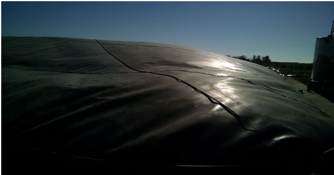
Fotografía 3: Membrana del biodigestor, la cual funciona como gasómetro, acumulando el biogás.
