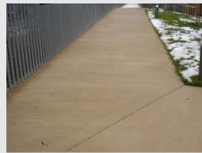
PISO DE HORMIGON RASPINADO
