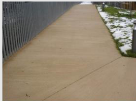
PISO DE HORMIGON RASPINADO
