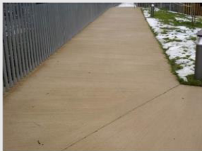
PISO DE HORMIGON RASPINADO
