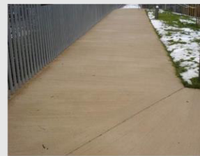
PISO DE HORMIGON RASPINADO
