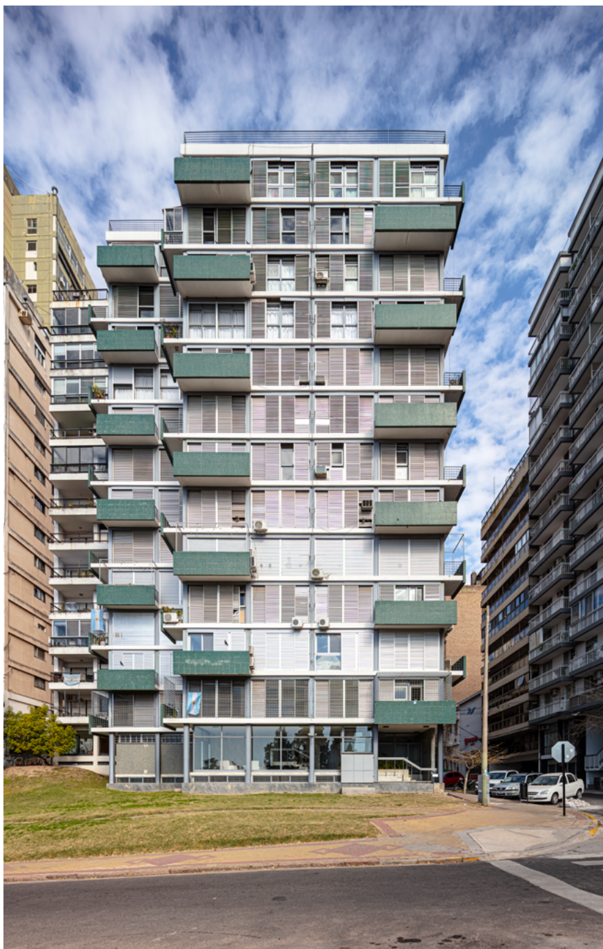
FIGURA 37. Vista lateral de los balcones del edificio Copacabana desde la calle Primero de Mayo. Fuente: Revista [o41] , n.º 3, 1999, 50.
