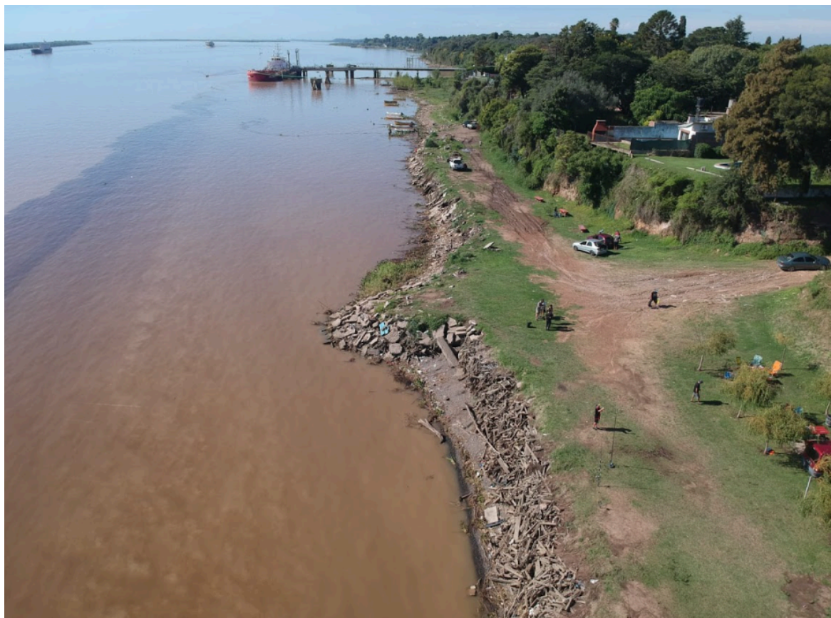
Imagen 6 - Fotografía aérea de la zona. Fuente: producción propia.
