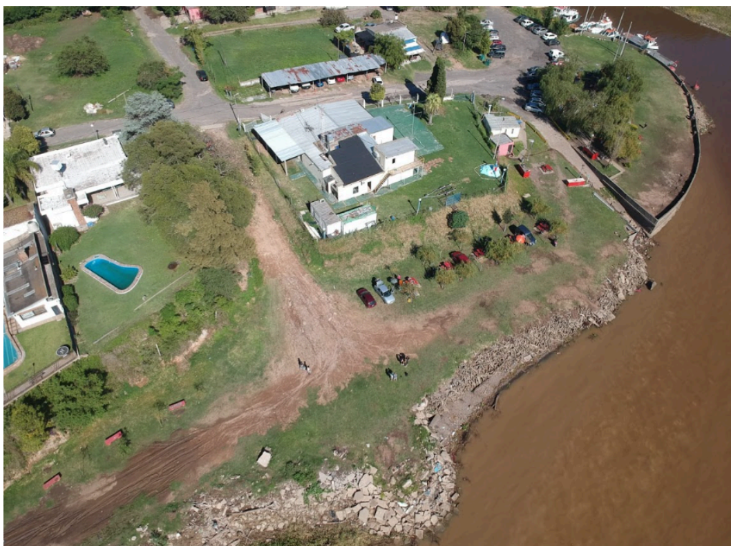
Imagen 7 - Fotografía aérea de la zona. Fuente: producción propia.
