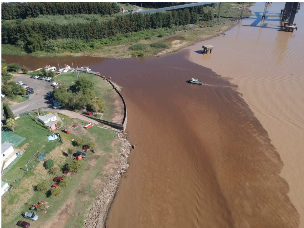
Imagen 8 - Fotografía aérea de la zona. Fuente: producción propia.
