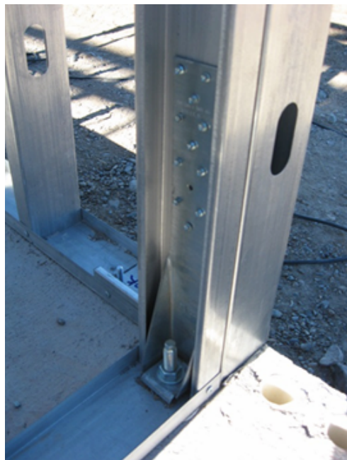
Imagen 40 - Anclaje químico materializado sobre una platea de fundación. Fuente: AD Barbieri.
