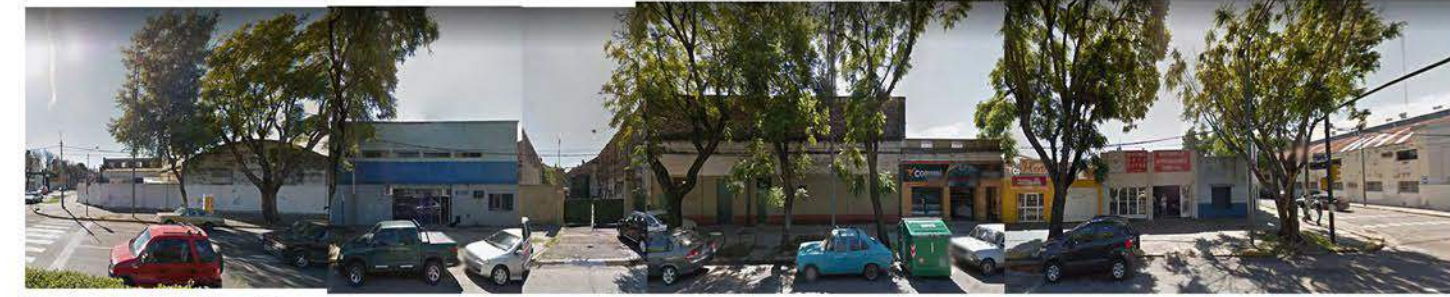
Fachada Av. Pellegrini
