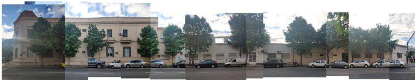
Fachada Ov. Lagos
