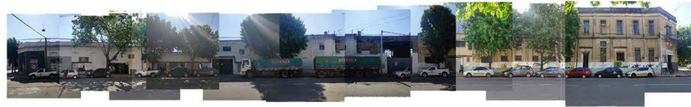
Fachada Ov. Lagos
