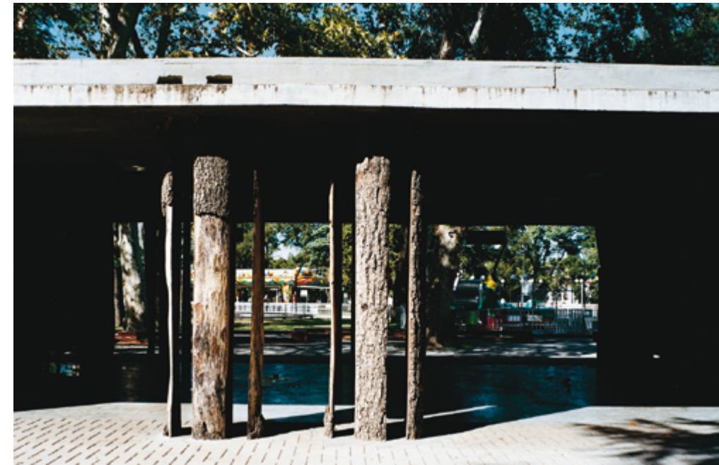
Figura 4. Pabellón de Fiestas. Fotografía: Gustavo Fritegotto (2003) | Figura 5. Casa De la Cruz. Fotografía: Gustavo Fritegotto (2007)
