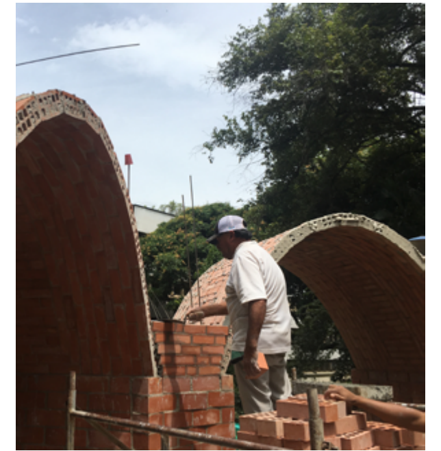
Paraboloide de ladrillos y bambú. Arquitectos Moran Ubidia y Alfonso Ramírez Ponce durante un taller en la Facultad de Arquitectura de Guayaquil (2012). Fotografía: Alfonso Ramírez Ponce. | Bóveda recargada de ladrillos realizada durante el Taller "Arcos, bóvedas y cúpulas" en la Escuela de Arquitectura de la Universidad del Valle, Colombia (2015).
