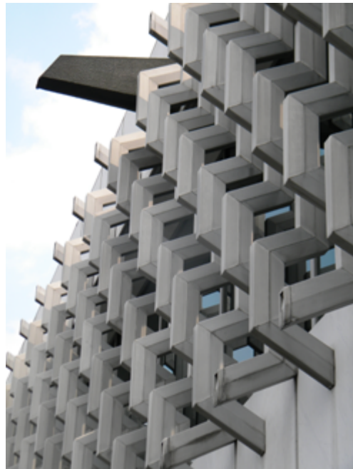
Museo Nacional de Antropología. Detalle de parasoles de aluminio y cribados de madera en el patio interior. Arquitecto Pedro Ramírez Vázquez (1964). Fotografía: Daniel Viu.
