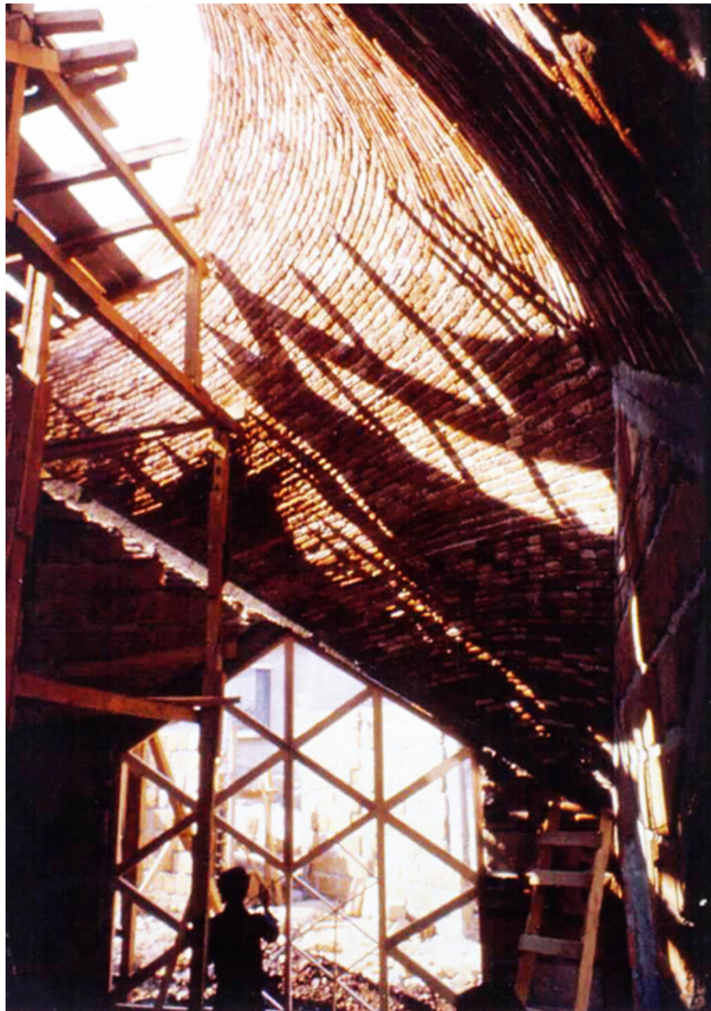
Casa CEDR CDMX. Fotografía: Alfonso Ramírez Ponce. Maestro bovedero. Bóveda recargada de ladrillos. Fotografía: Alfonso Ramírez Ponce.
