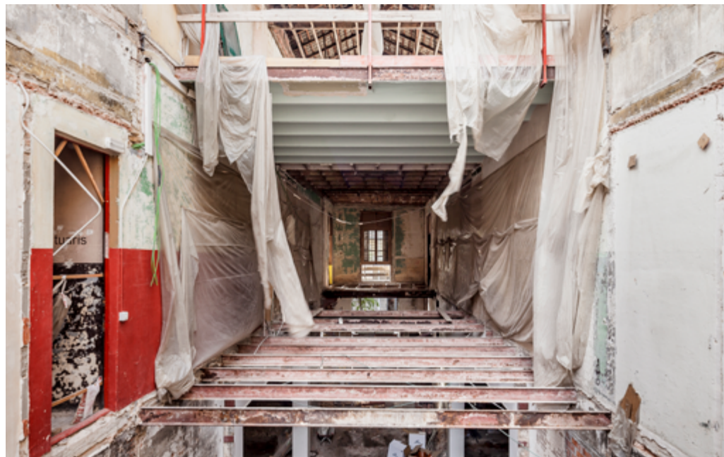
Obra de la nueva Sala Beckett. Fotografía: Adrià Goula.
