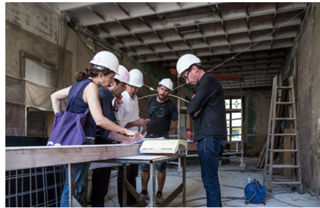
Dirección de obras de la nueva Sala Beckett. Fotografía: Judith Casas.
