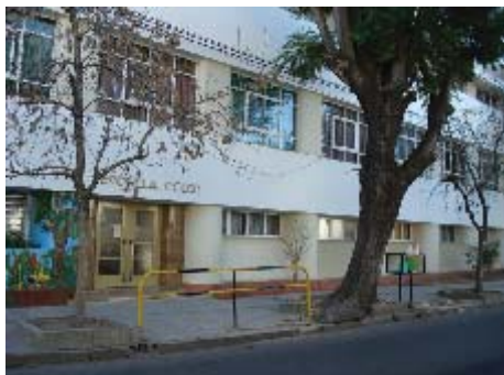
Escuela Cristóbal Colón Estado actual
