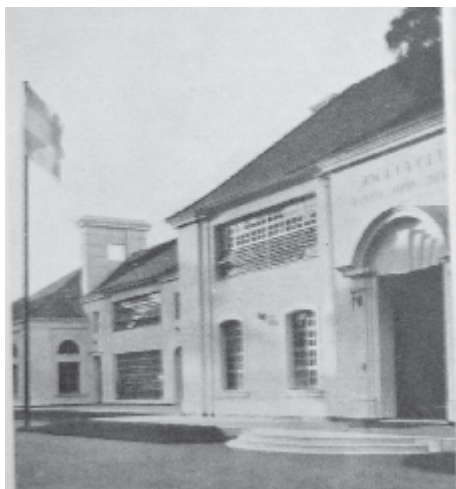
Escuela y jardín del Jockey Club. 1929 Fachada principal y detalle de fachada. Fuente: Cuadernos de arquitectura, 1938, p. 85.
