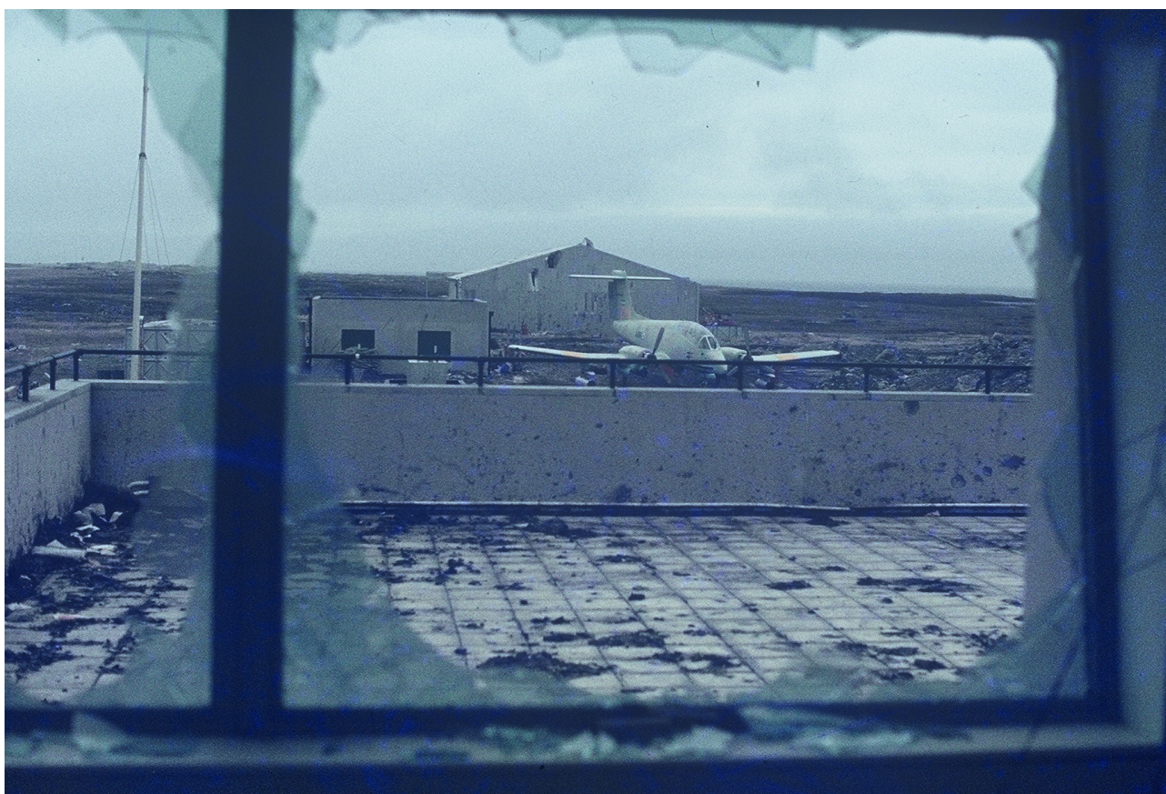
1º de mayo: torre de vuelo destruída en el aeropuerto. Fotografía de Nicolás Kasanzew.
