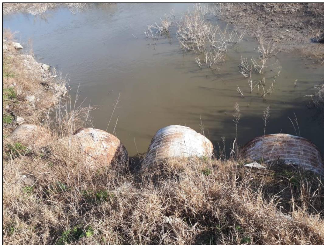
Figura N°E4: Imagen de obra N°3.
