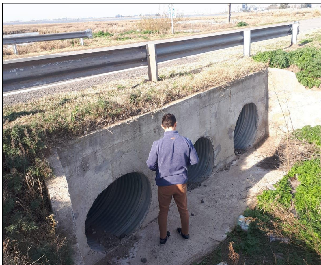
Figura N°E6: Imagen de obra N°5.
