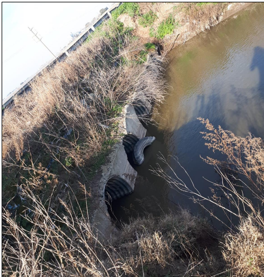
Figura N°E3: Imagen de obra N°2.
