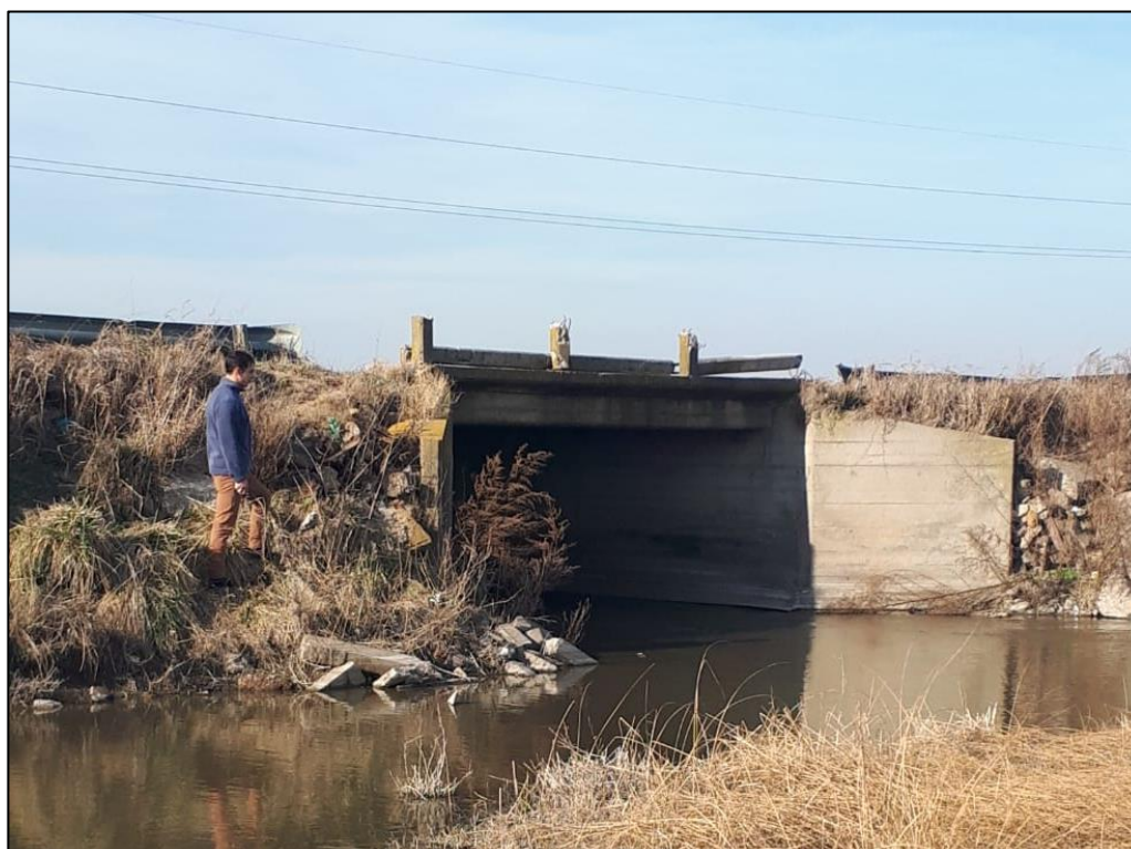
Figura E2: Imagen de obra N°1.
