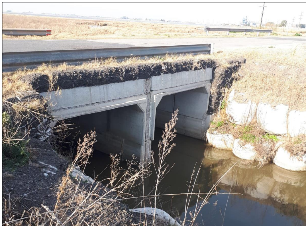
Figura N°E5: Imagen de obra N°4.
