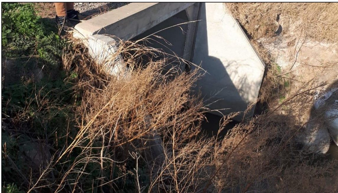
Figura N°E7: Imagen de obra N°6.
