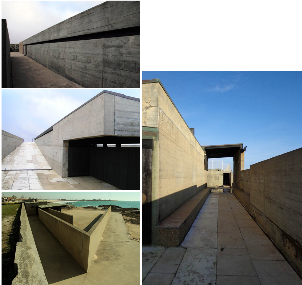
Las piscinas de mar en Leça da Palmeira / Alvaro Siza
