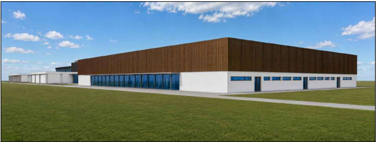
IMÁGEN 4 - FACHADA SUR Y OESTE, SECTOR EVENTOS
