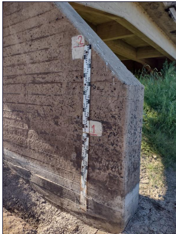
Imagen N° 2.3.7. Relevamiento Estructural Muro de Pilas. Escala hidrométrica.
