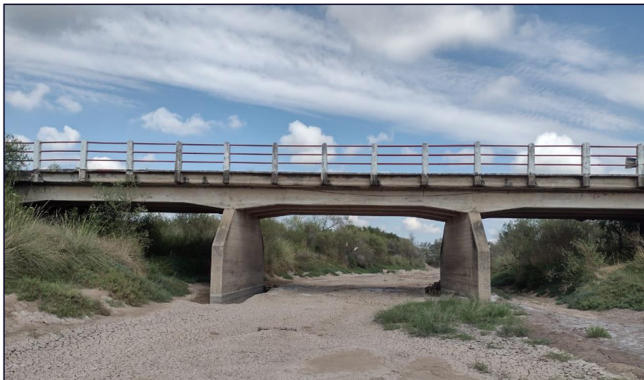
Imagen N° 2.4.2. Vista Lateral Muro de Pila.
