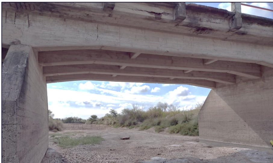
Imagen N° 2.3.5. Relevamiento Estructural Vigas Longitudinales – Viguetas Transversales.
