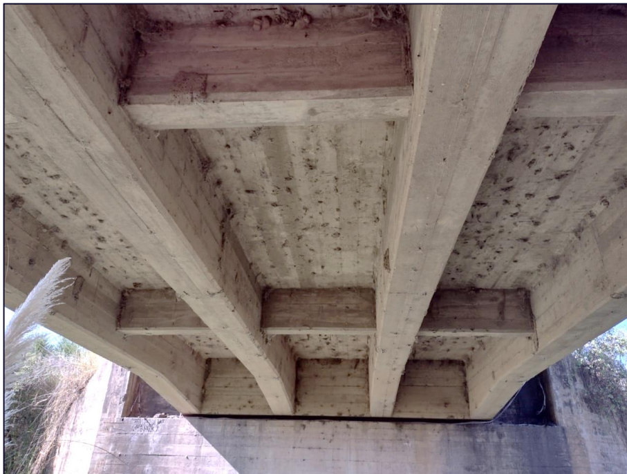
Imagen N° 2.3.4. Relevamiento Estructural Vigas Longitudinales – Viguetas Transversales.
