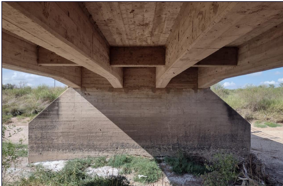
Imagen N° 2.4.3. Vista frontal de Muro de Pila.
