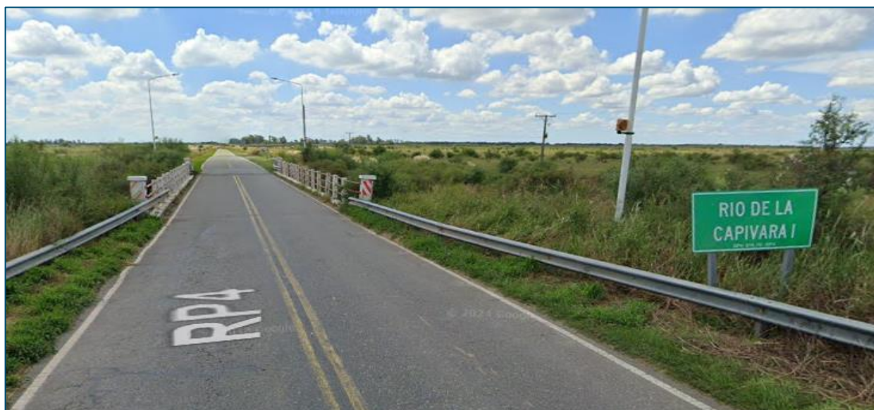
Imagen N° 2.1.3. Acceso de Puente desde Sur. Ruta Provincial N°4.
