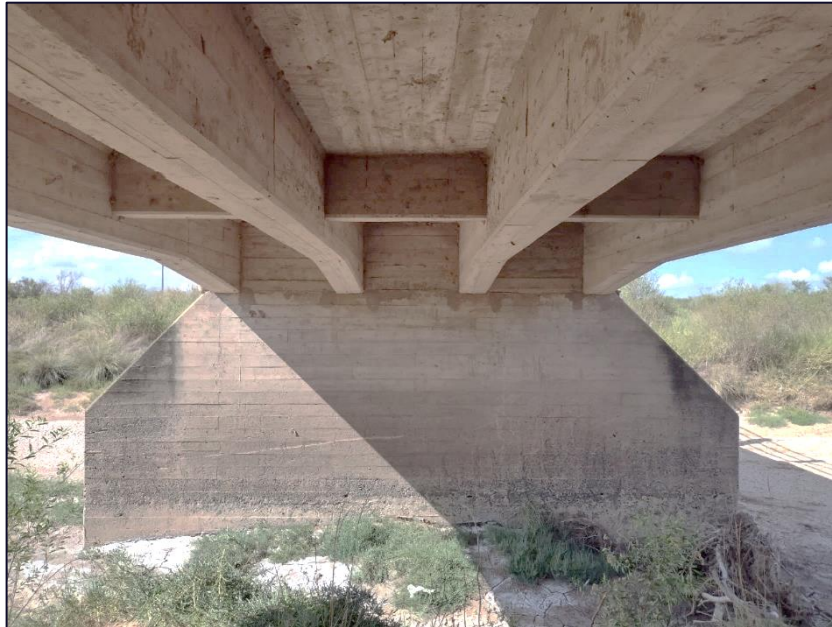
Imagen N° 2.3.6. Vista Frontal Muro de Pila. Relevamiento Estructural.
