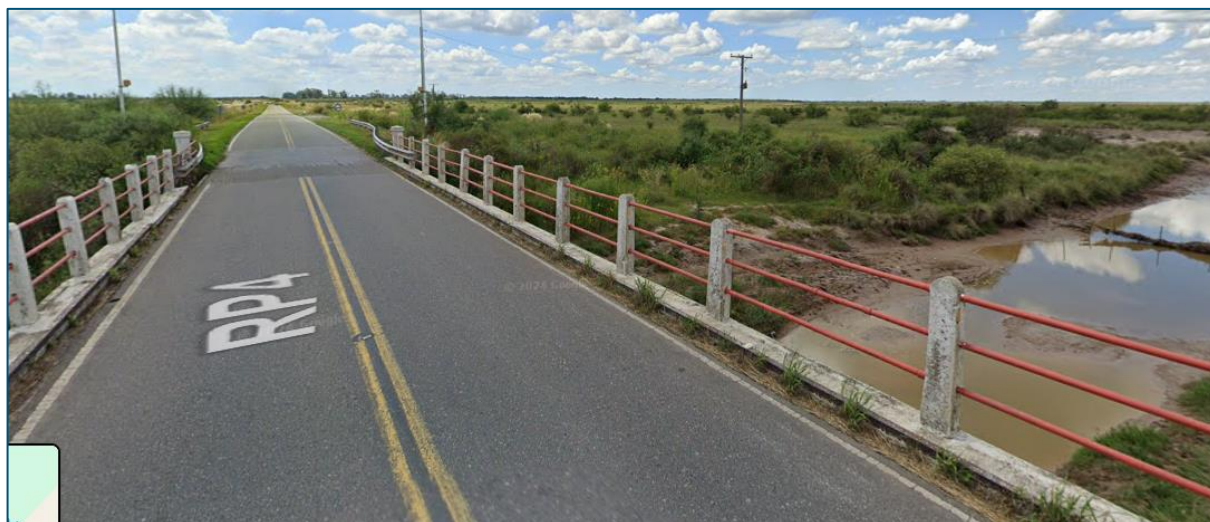
Imagen N° 2.1.5. Vista Este desde Puente en estudio.
