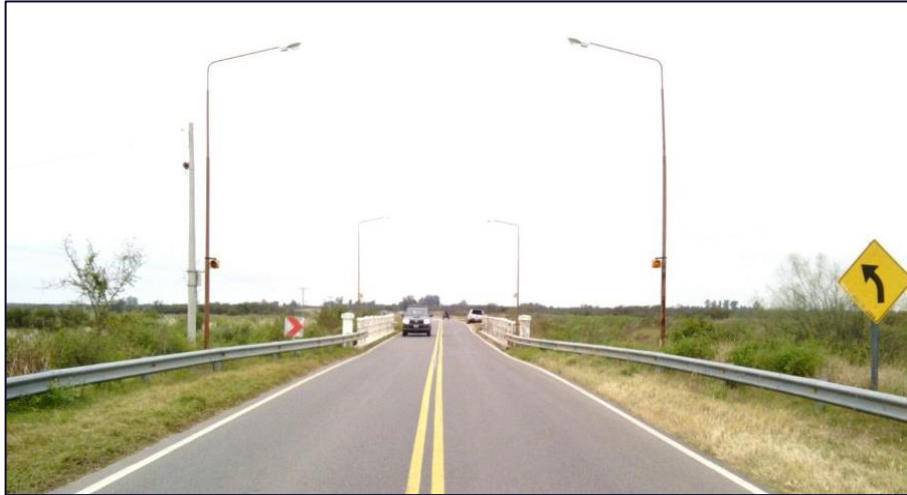
Imagen N° 2.4.1. Acceso Sur a puente.
