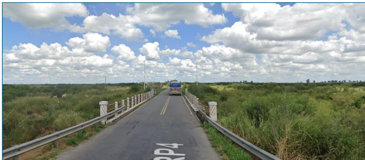
Imagen N° 2.1.7. Acceso de Puente desde Norte. Ruta Provincial N°4.
