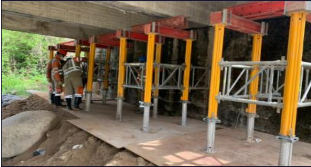
Imagen N° 3.5.19. Posible estructura auxiliar para levantamiento de puente.
