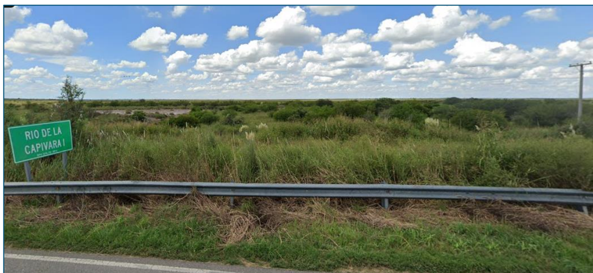
Imagen N° 2.1.4. Entorno Puente en estudio.
