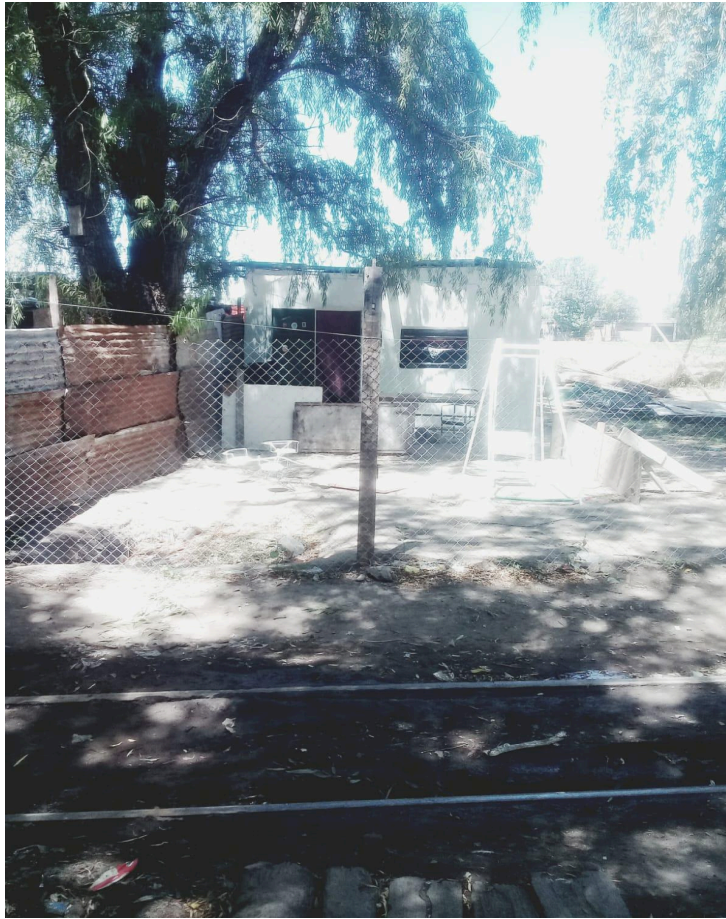
Imagen N°4: la planta baja terminada, vista desde las vías del tren. Rosario, abril 2017.
