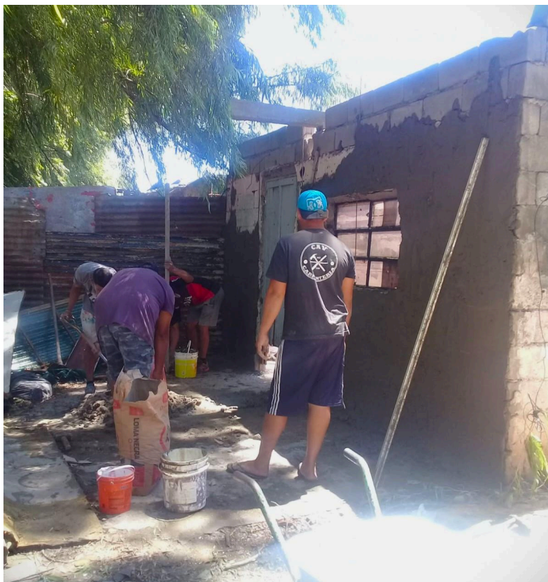
Imagen N°3: trabajadores comunitarios construyendo “el barrial”. Rosario, abril 2017.
