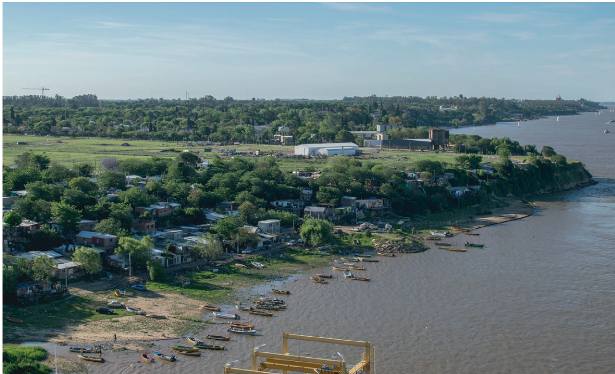
DESDE PLANTA POTABILIZADORA.
