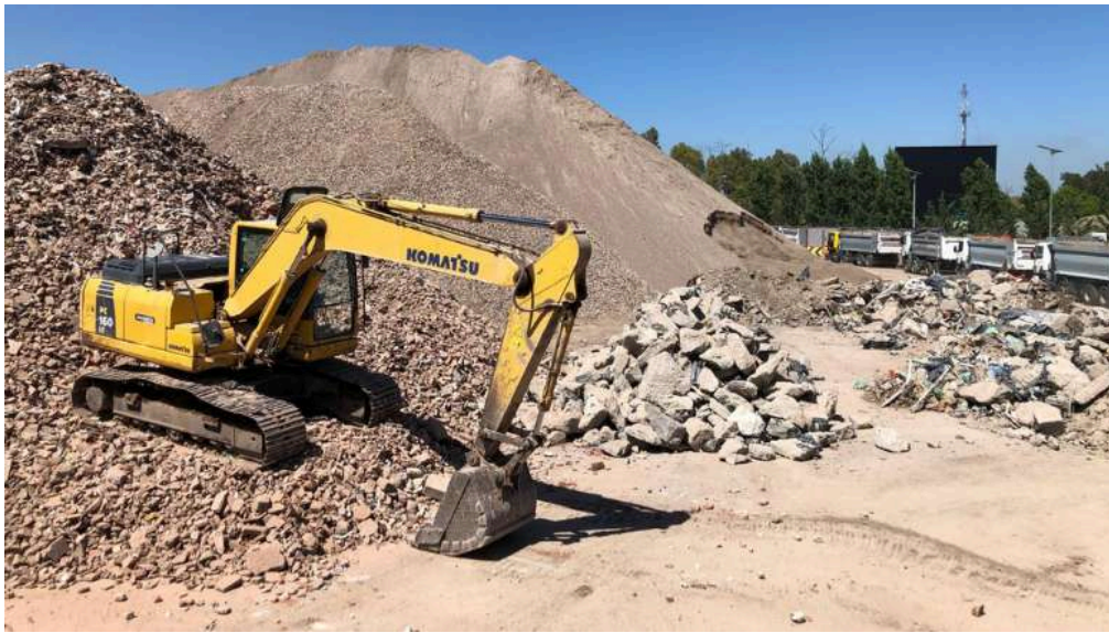
Figura N°27: Tratamiento de residuos de demolición y construcción (Fuente: Imágenes de Google)
