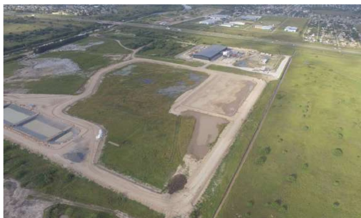
Figura N° 20: Vista aérea del centro GRSU Corredor Sur Metropolitano (Fuente: SantaFe.gob.ar )
