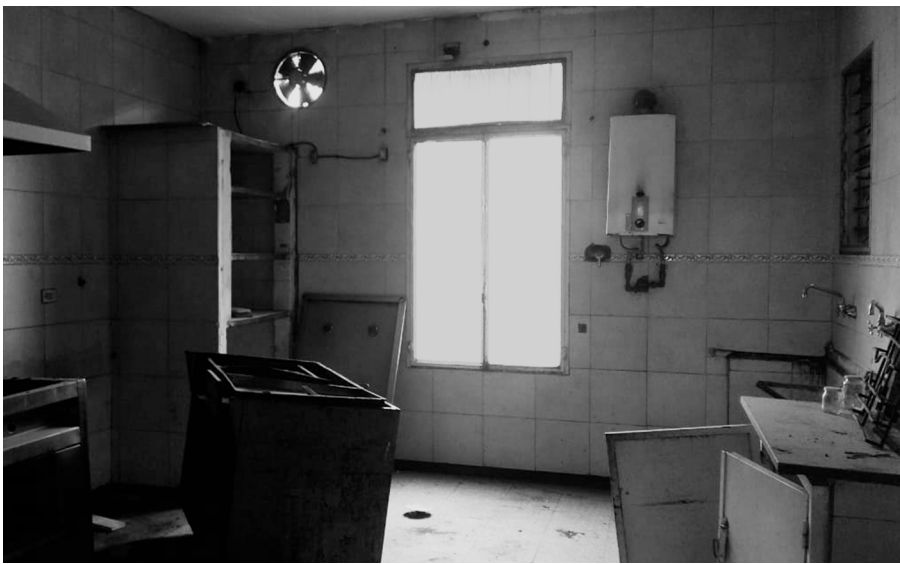
Imagen: Fotos del estado actual del edificio existente. Fuente: Archivo del Ministerio de Seguridad de Santa Fe.
