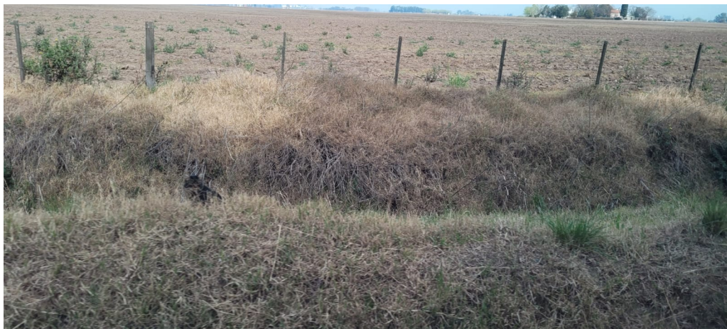
Figura I - Estado actual de la cuneta.
