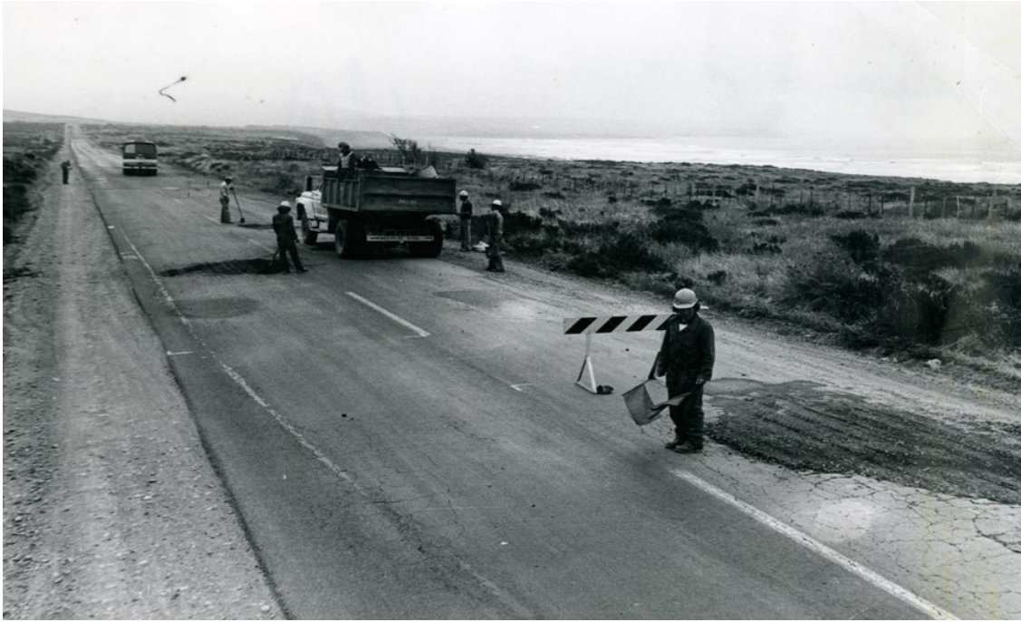
Fig. 5.6 Construcción carretera panamericana Norte 1969. Fuente: https://www.infraestructurapublica.cl
