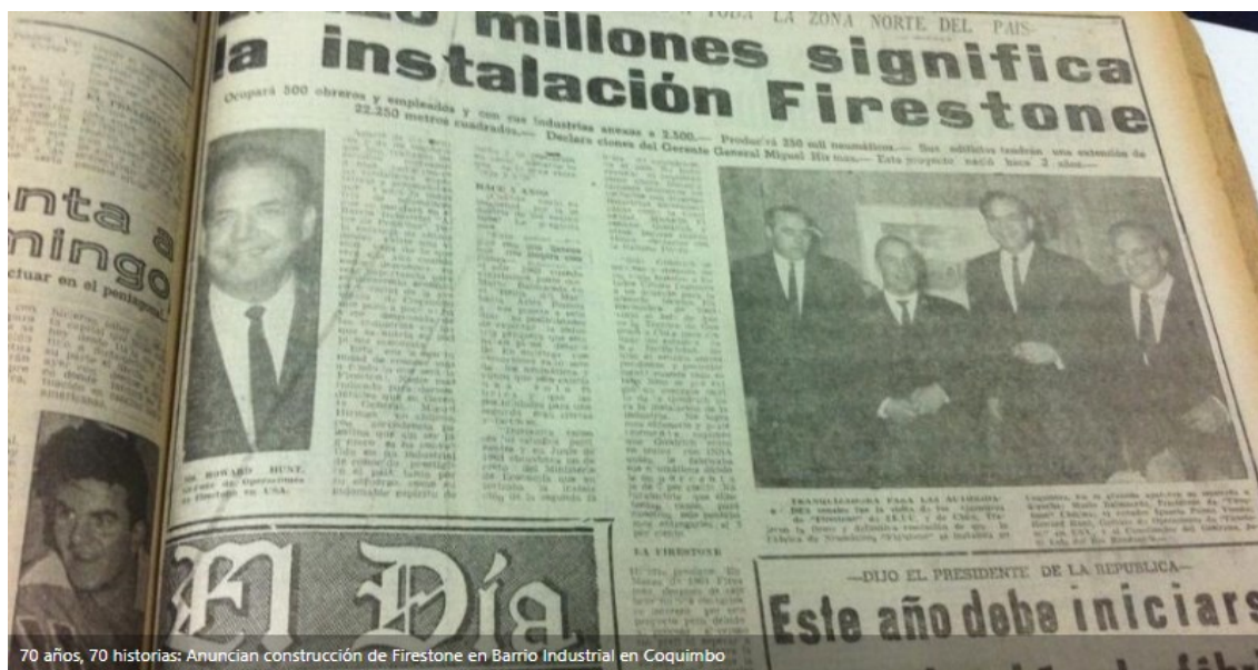
Fig. 5.9 Instalación Fabrica de neumáticos FIRESTONE 1966. Fuente: Diario el Día 2020.
