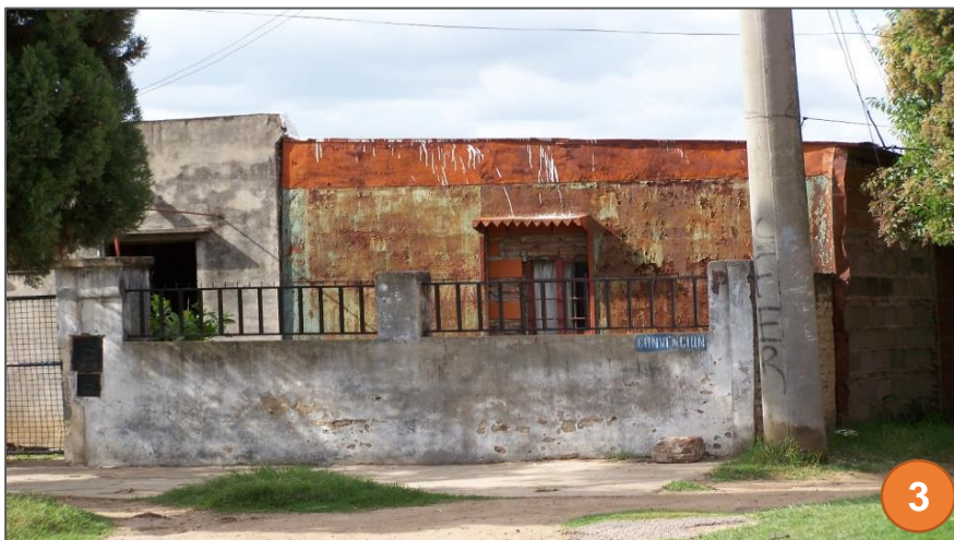
Figuras 21-22-23. Casas típicas del sector Noreste del barrio Tablada: 1) Cubierta con tablas de madera; 2) Armada con chapones lisos y con chapas acanaladas en forma vertical; y 3) Forrada con latas de kerosene y tambores de 200 litros
