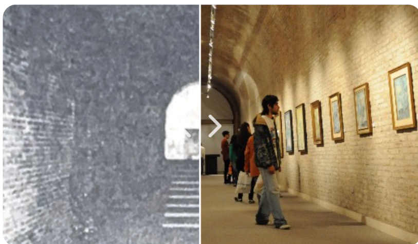
Imagen 24. Yuxtaposición de uno de los túneles.
