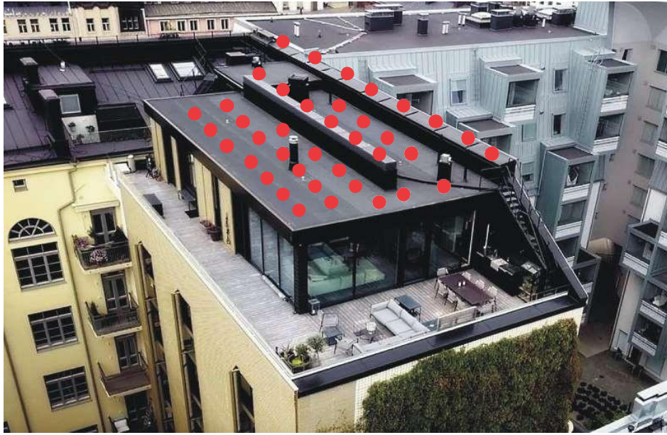
Figura 53: Cada punto rojo representa a cada medición de velocidad 3D en la superficie de la azotea de un edificio. Elaboración propia.
