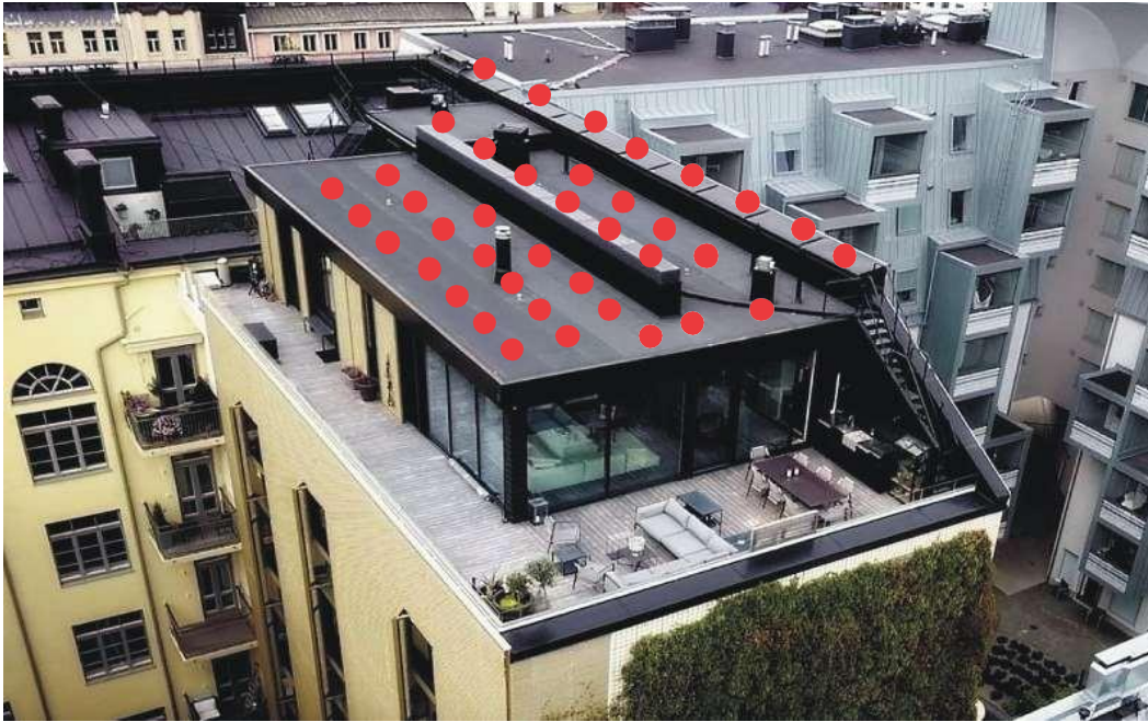
Figura 5: Estudio del viento urbano en la azotea de un edificio. Los puntos rojos muestran los diferentes puntos de medición con anemómetro 3D de coperolas. Elaboración propia.
