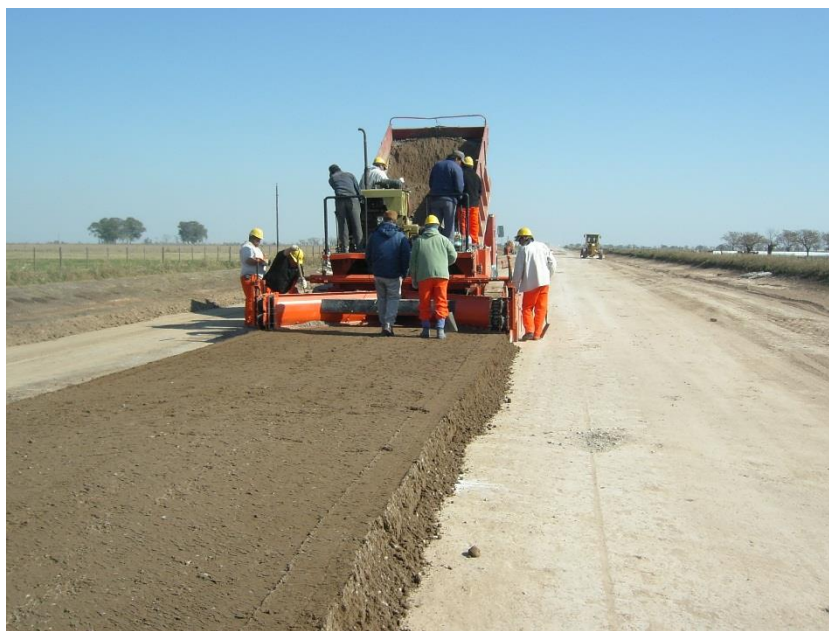
Imagen n° 11: Colocación mediante terminadora. (Fuente: Archivo Dirección Obras DPV Santa Fe)
