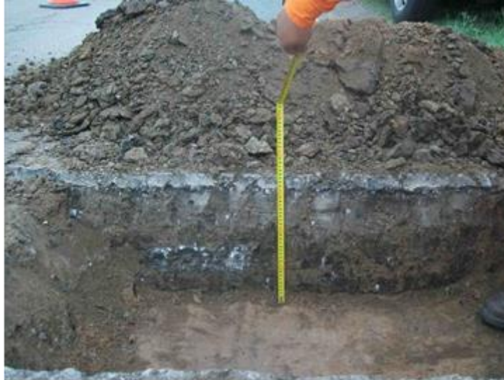
Imagen n° 41: Apertura de calicata. (Fuente propia).
