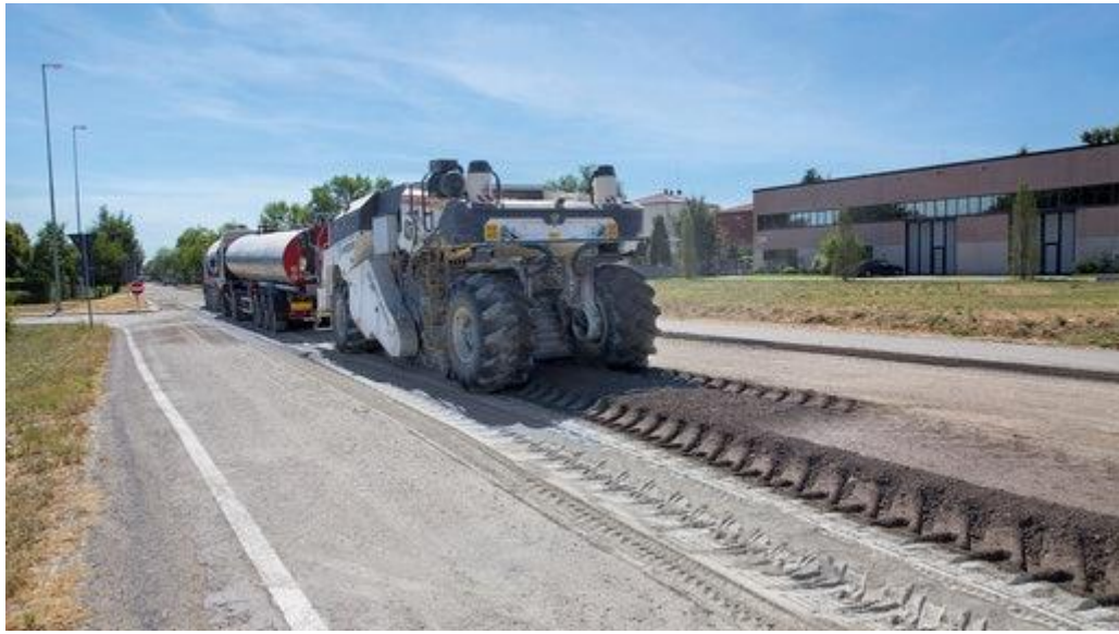
Imagen n° 19: Técnica de reciclado en frío con incorporación de cemento. (Fuente: Grupo Wirtgen).
