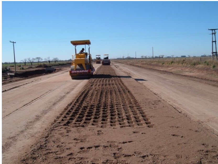
Imagen n° 7: Compactación base cementada. (Fuente: Archivo Dirección Obras DPV Santa Fe)
