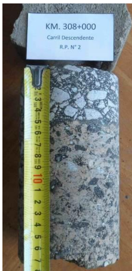
Imagen n° 40: Calado de testigos sobre RP2 (fuente propia).
