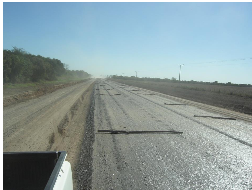
Imagen n° 8: Base curada y terminada. (Fuente: Archivo Dirección Obras DPV Santa Fe)
