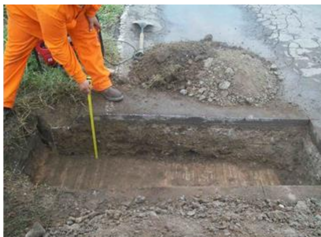
Imagen n° 48: Apertura de calicata. (Fuente propia).
