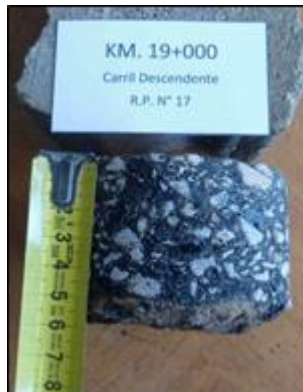
Imagen n° 47: Calado de testigos sobre RP17 (fuente propia).
