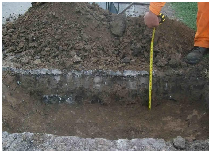
Imagen n° 37: Apertura de calicata sobre RP2 (fuente propia).
