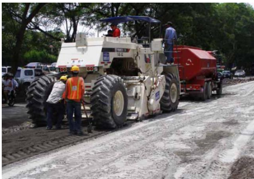
Imagen n° 5: Ejecución de base cementada. (Ing. Arce, 2011) [25]
