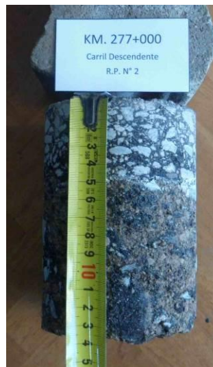
Imagen n° 36: Calado de testigos sobre RP2 (Fuente propia).
