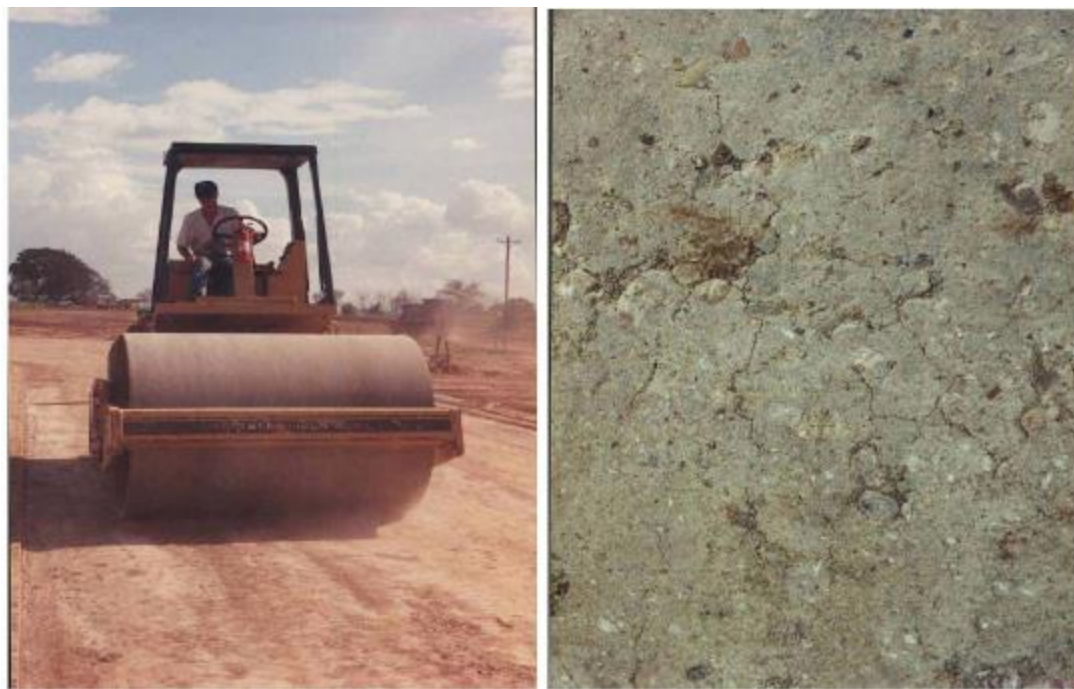
Imagen n° 18: Pasada de rodillo para microfisuración (izquierda). Vista de base microfisurada (derecha). (Scullion, 2002) [42].
