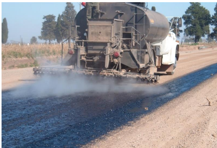
Imagen n° 9: Aplicación riego de curado mediante camión regador. (Fuente: Archivo Dirección Obras DPV Santa Fe)
