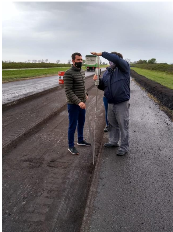
Imagen n° 31: Ejecución ensayo de penetración (DCP) sobre rutas provinciales.
