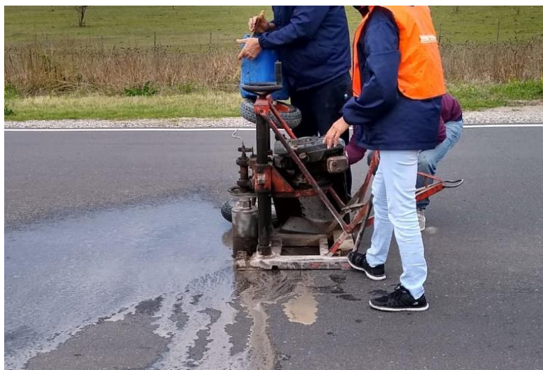
Imagen n° 29: Calado de testigos sobre RP90.
