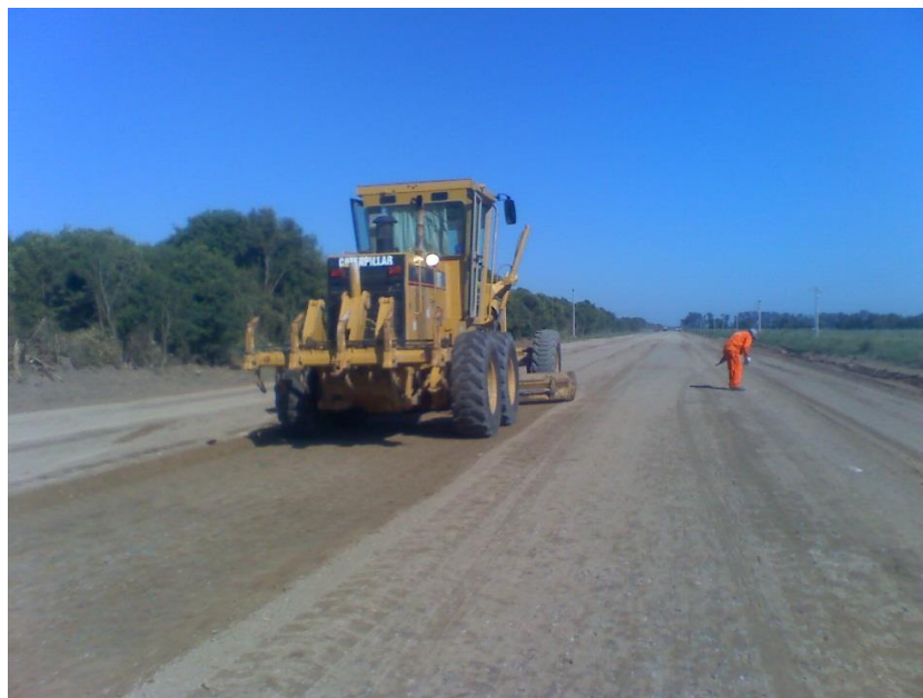
Imagen n° 6: Preparación de la superficie (Fuente: Archivo Dirección Obras DPV Santa Fe).
