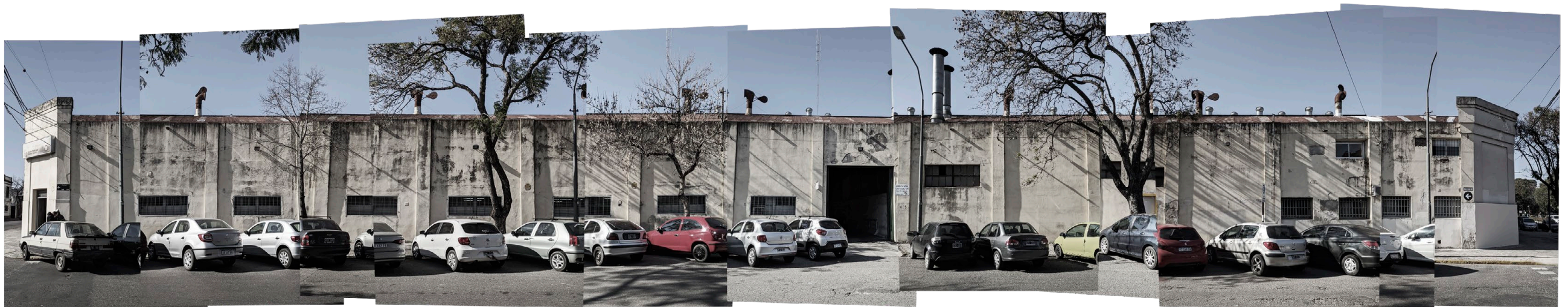
FACHADA OESTE - RICHERI
