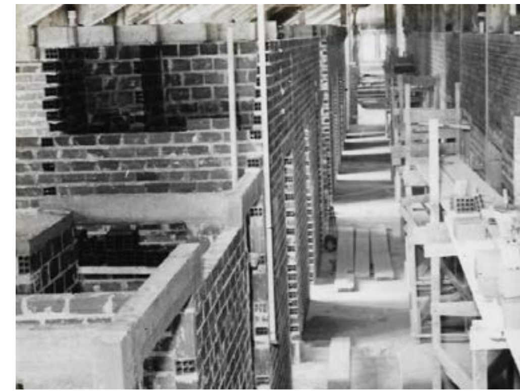
Proceso de obra, 1954. Fuente: Archivo DNA
