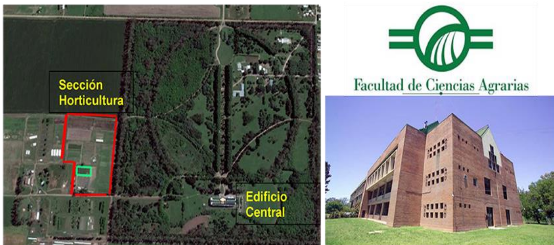
Figura 7: imagen satelital del Campo Experimental J. Villarino, en el cual se ubica la Sección de Horticultura y el Edificio Central de la Facultad de Ciencias Agrarias, Universidad Nacional de Rosario. Localidad de Zavalla, Santa Fe, Argentina.
