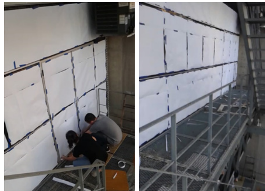
Montaje de obra.
