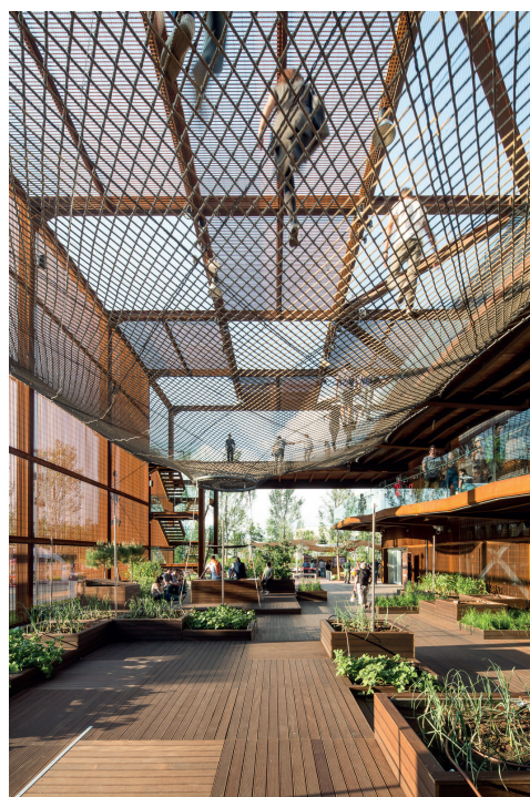
Fig. 46. Pabellón Brasil Milán: redes como elemento de protección y también lúdico, rampa de acceso. Fuente: https://www.plataformaarquitectura.cl/cl/766787/pabellon-de-brasil-expo-milan-2015-studio-arthur-casas-plus-atelier-marko-brajovic
