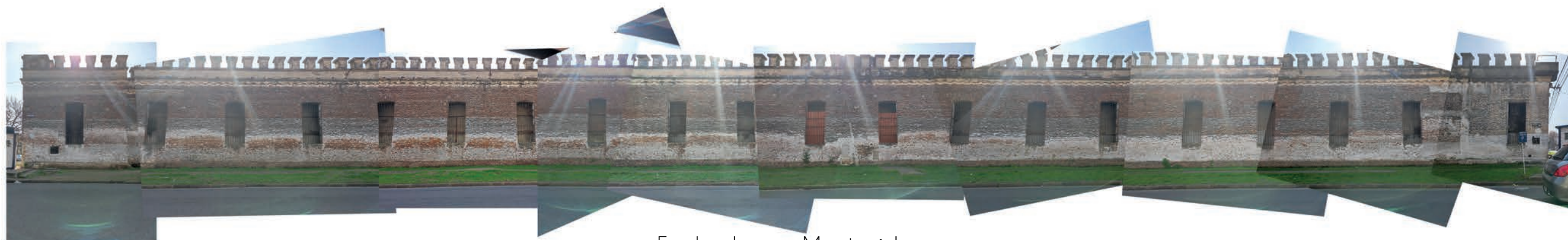
Fachada por Montevideo
