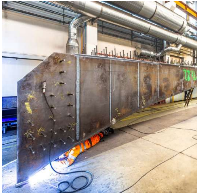
Figura 3.5: Proceso de soldadura de la viga cajón en taller [28]
