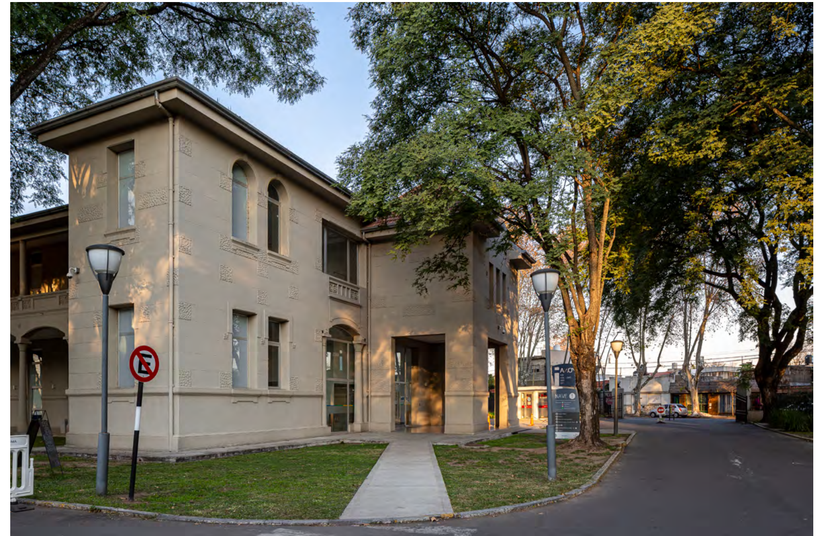
Sector polo tecnológico - Zona i Ingreso principal al conjunto y fachada de la Nave 1
