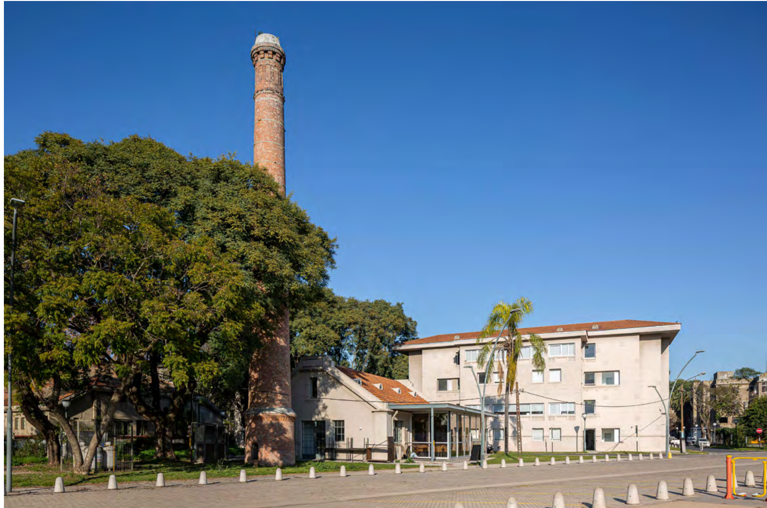
Vista sector polo tecnológico y bar. Fachada este
