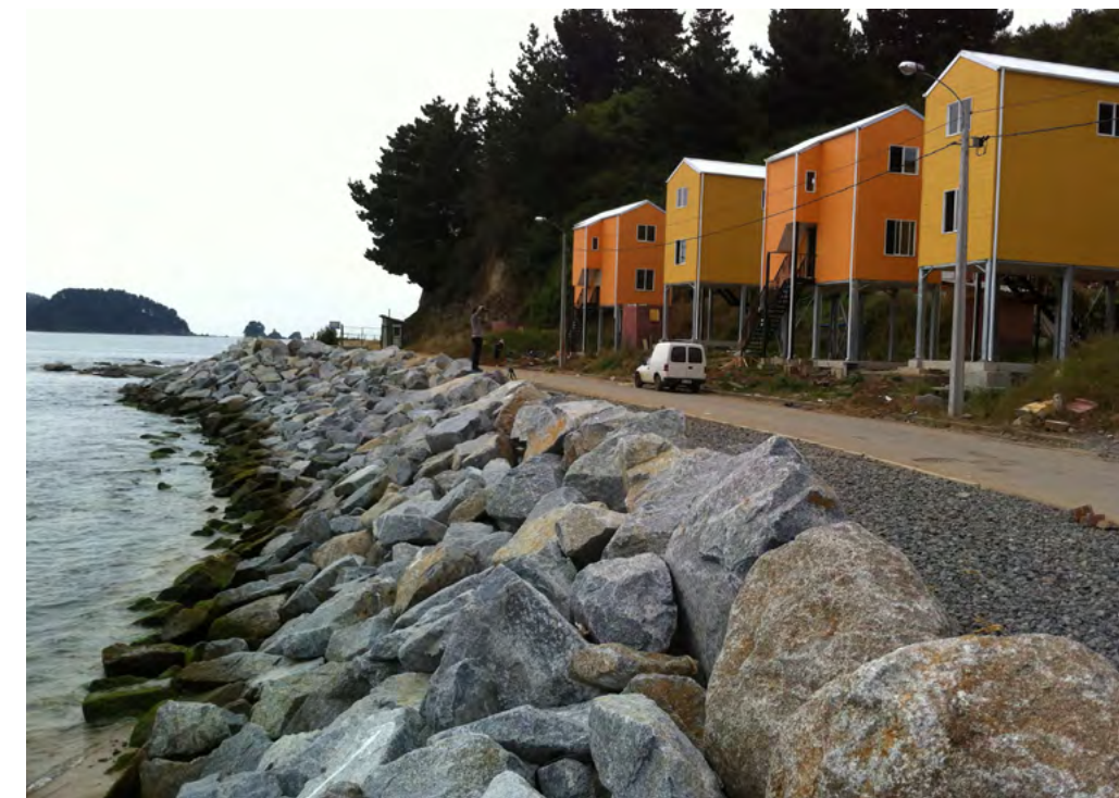
Figura 4. Plan Maestro de Reconstrucción del Borde Costero, Dichato, región de Bío Bío, Chile. Viviendas resilientes. Fotografía: Sergio Baeriswyl.
