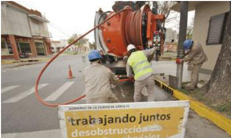
Desobstrucción de desagües pluviales
