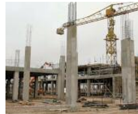
Hospital Rosario Sur - En ejecución primera etapa $ 50.000.000 | 24.000 m 2 | 110 camas
