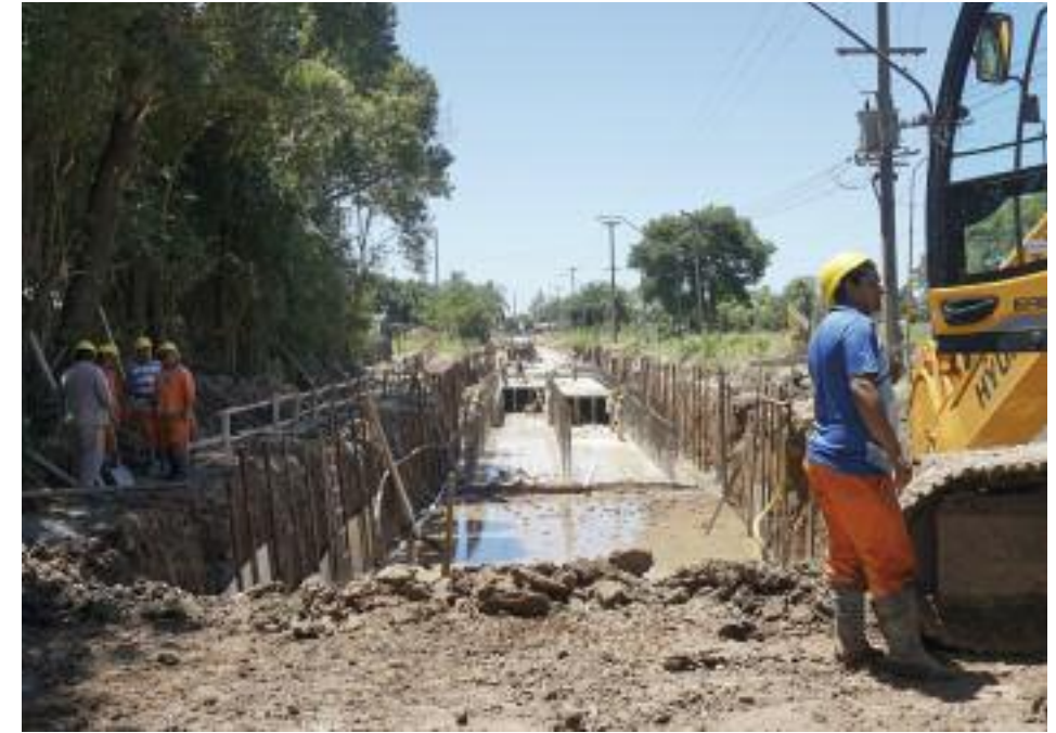
Terraplén Garello sobre el Colastiné
