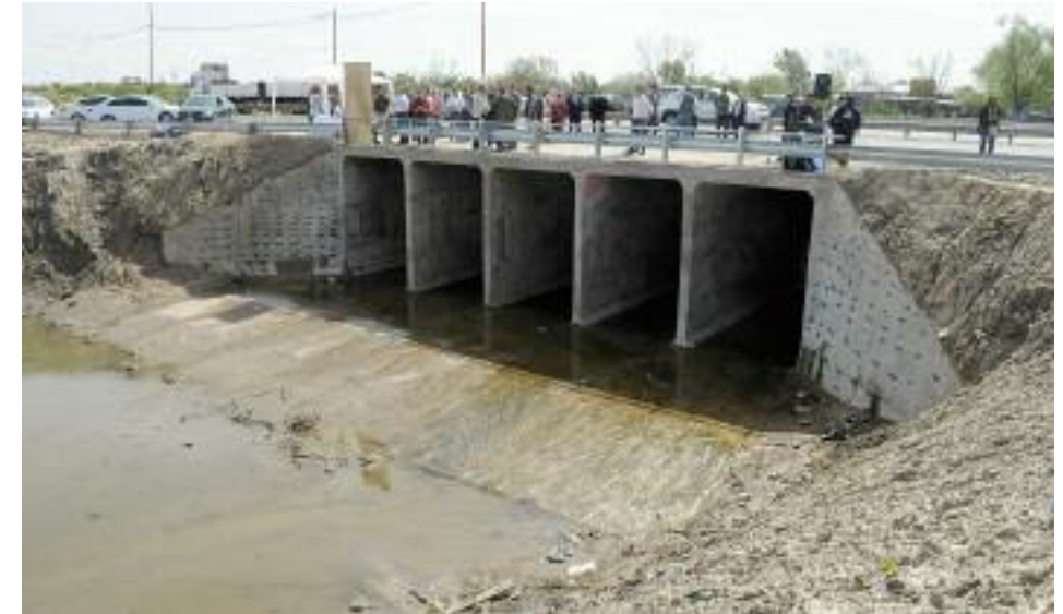
Obras de refuncionalización de Estación de Bombeo N° 1 - Alcantarilla cruce sobre av. Circunvalación
