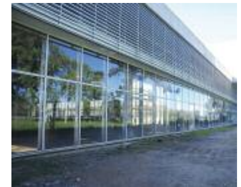
Hospital Venado Tuerto - En ejecución primera y segunda etapa | $ 73.000.000 | 17.000 m 2 | 98 camas
