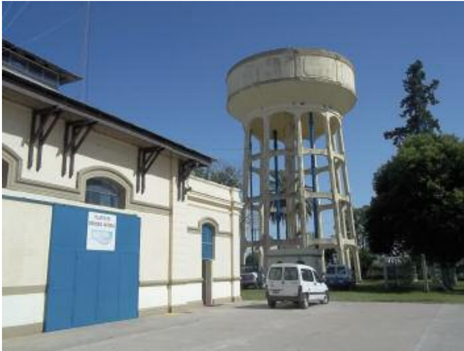
Planta potabilizadora de Ósmosis Inversa en Rafaela
