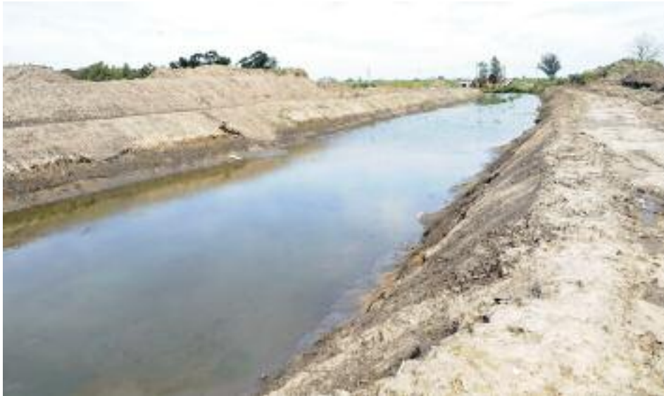
Terraplenamiento y readecuación reservorios
