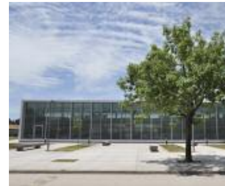
Hospital Las Parejas - Terminado $ 25.000.000 | 1900 m 2 | 14 camas
