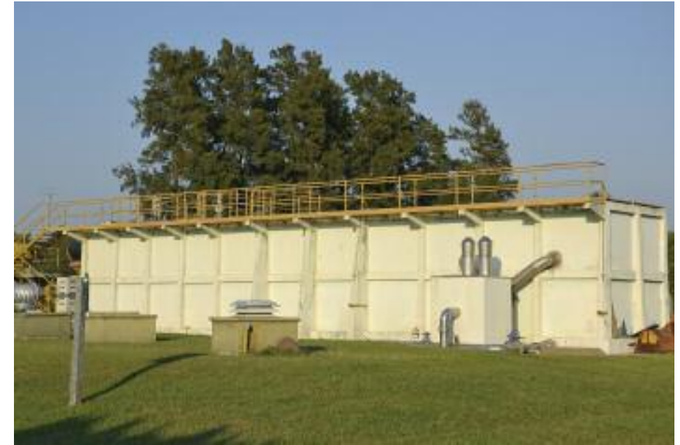
Planta potabilizadora Romang
