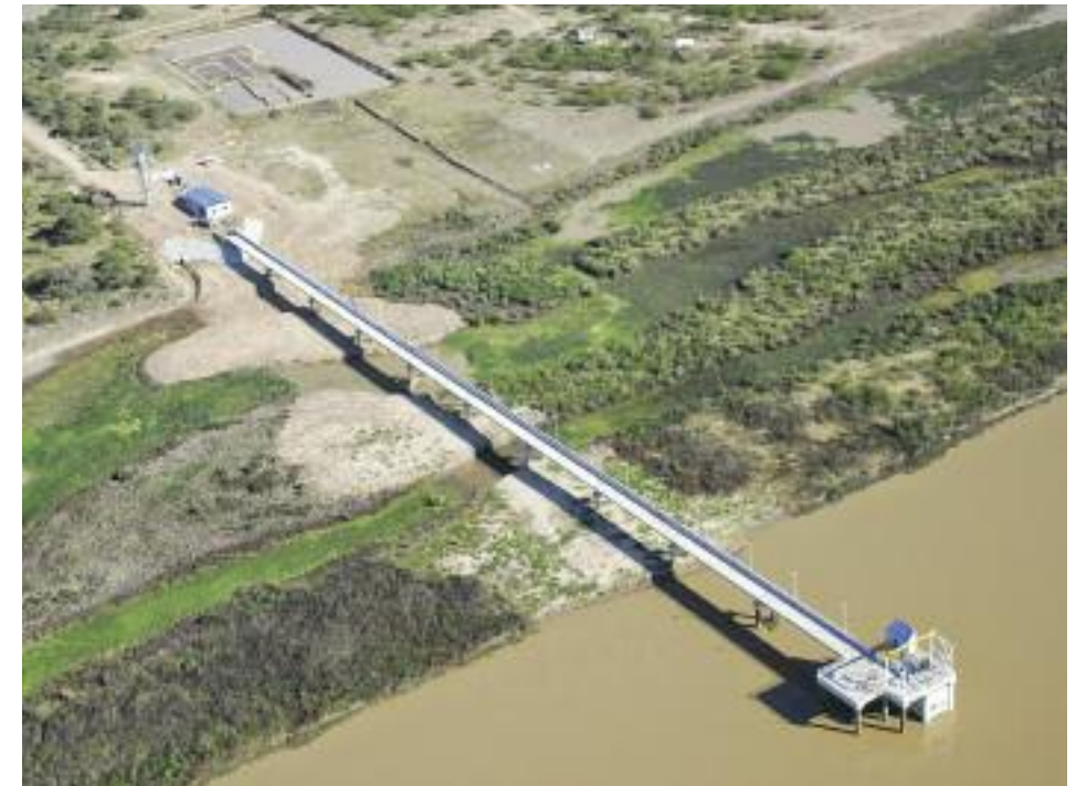
Toma de agua superficial. Desvío Arijón
