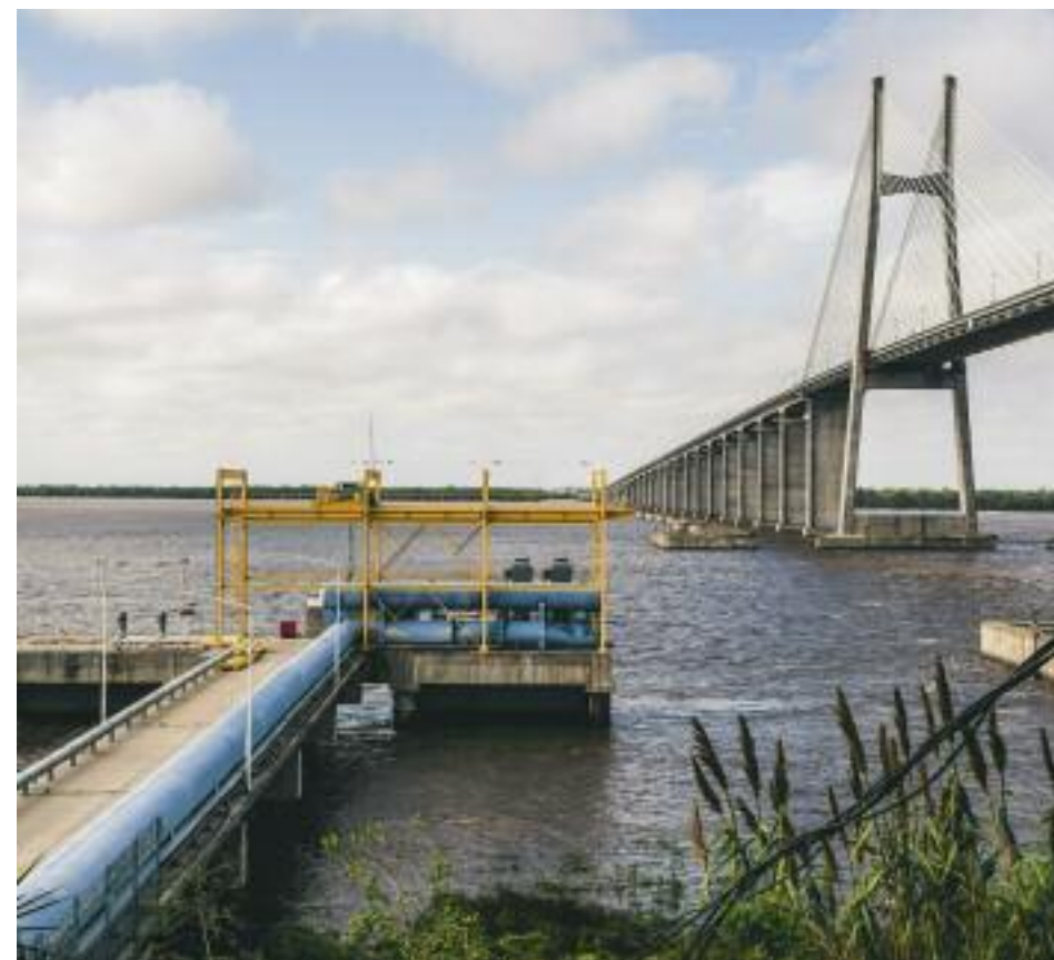
Toma de agua superficial. Granadero Baigorria
