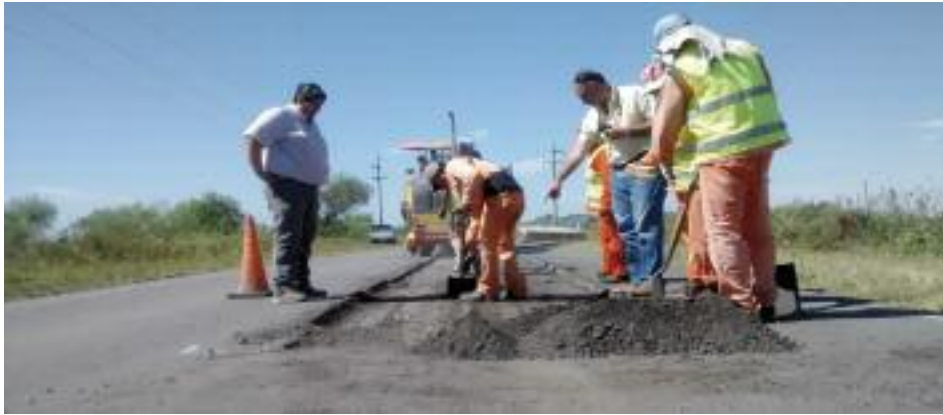
Repavimentación rutas provinciales
