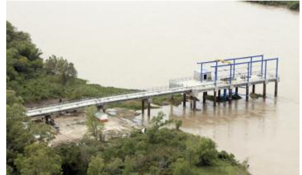
Acueducto Norte 1 - Desvío Arijón
