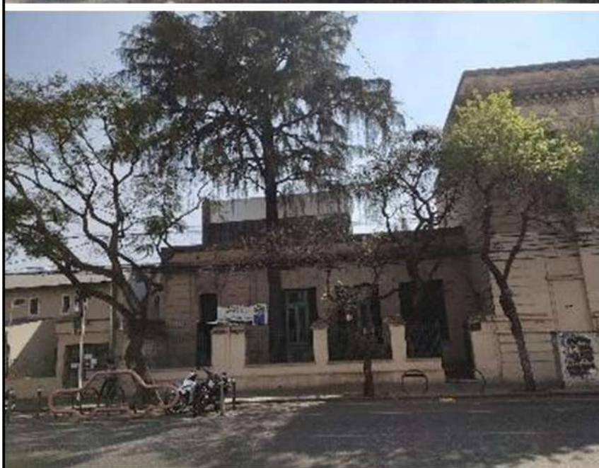
Imagen fachadas escuela Almafuerde e ingreso Escuela Mazza (ala oeste).
