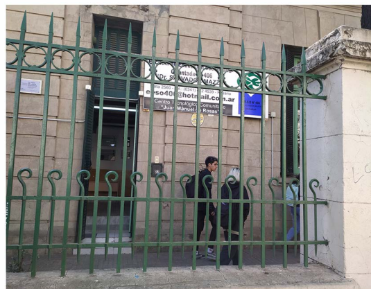
94- Reja del patio que separa puerta ingreso y vereda.
