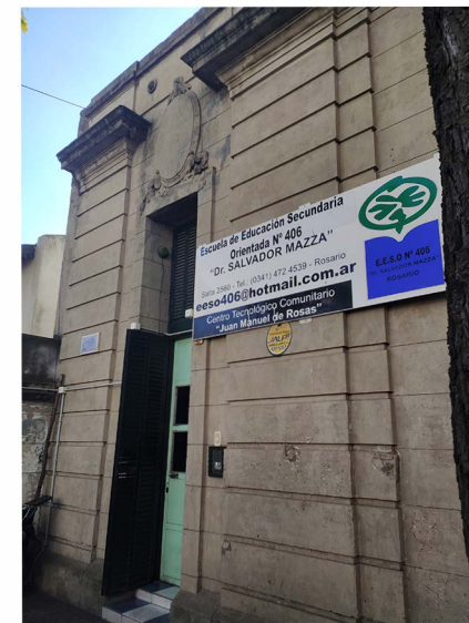
82- Puerta ingreso, con escalones y postigón.
