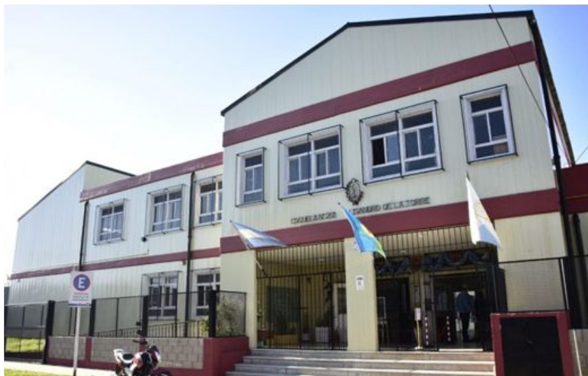
220- Fachada: escalinata de ingreso.
