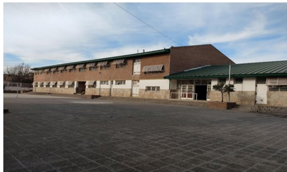
279- Vista trasera de la escuela, acceso al patio.
