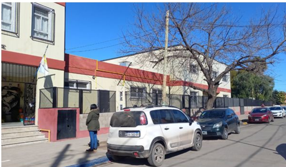
222- Hacia la derecha del acceso principal, gimnasio con ingreso independiente.
