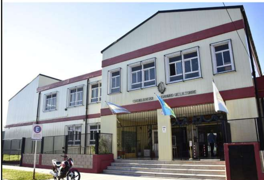
Imagen fachada principal.
