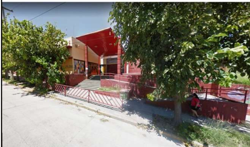
Imagen fachada principal.
