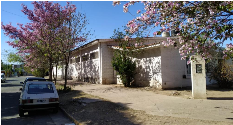
24- Emplazada en un lote esquina preexistente, originalmente sede de punta de línea de colectivos.
