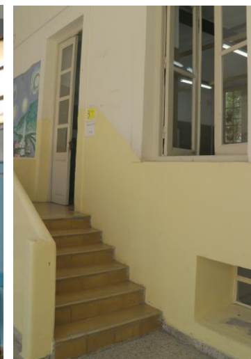
17- El ingreso a las aulas planta baja.
