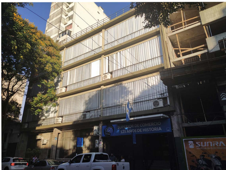
108- Fachada principal desde calle Balcarce.
