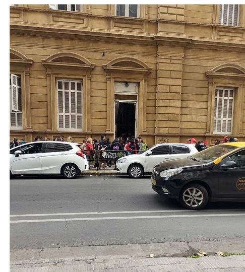
68- Ingreso y salida nivel secundario a calle Entre Ríos.
