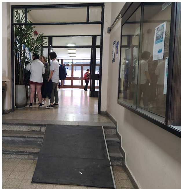
129- Rampa en escalones que conectan hall de ingreso con aulas planta baja.
