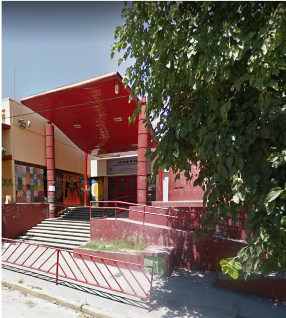
50- El ingreso del edificio cuenta con escaleras, rampa lateral y baños para discapacitados.
