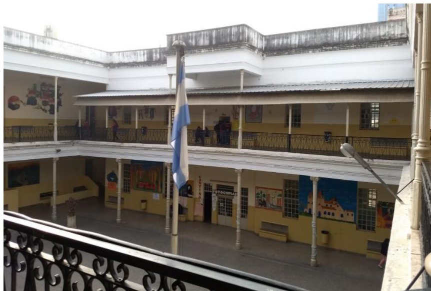
13- La escuela funciona en dos plantas con accesos mediante escaleras.
