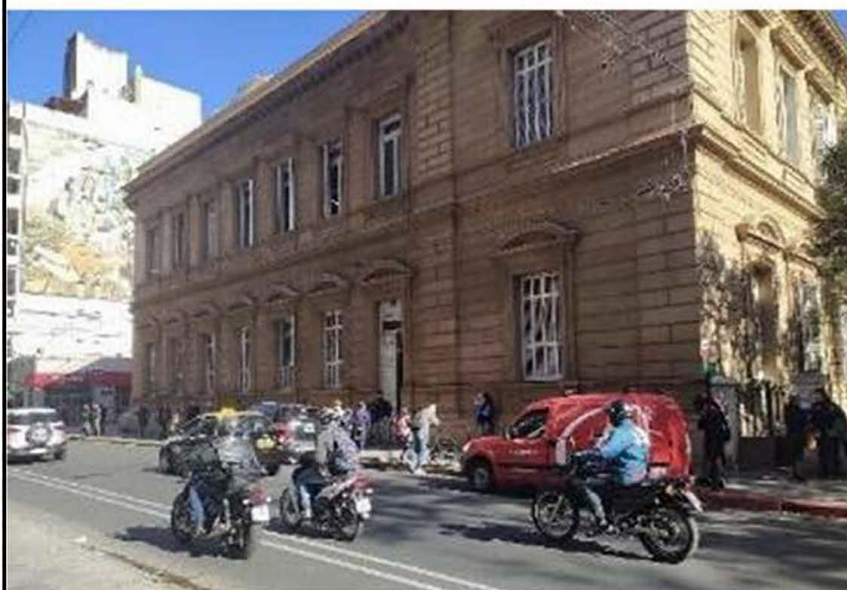
Imagen fachada calle Entre Ríos (ingreso nivel secundario).
