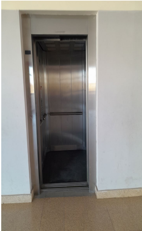
303- Ascensor de acceso al primer piso.
