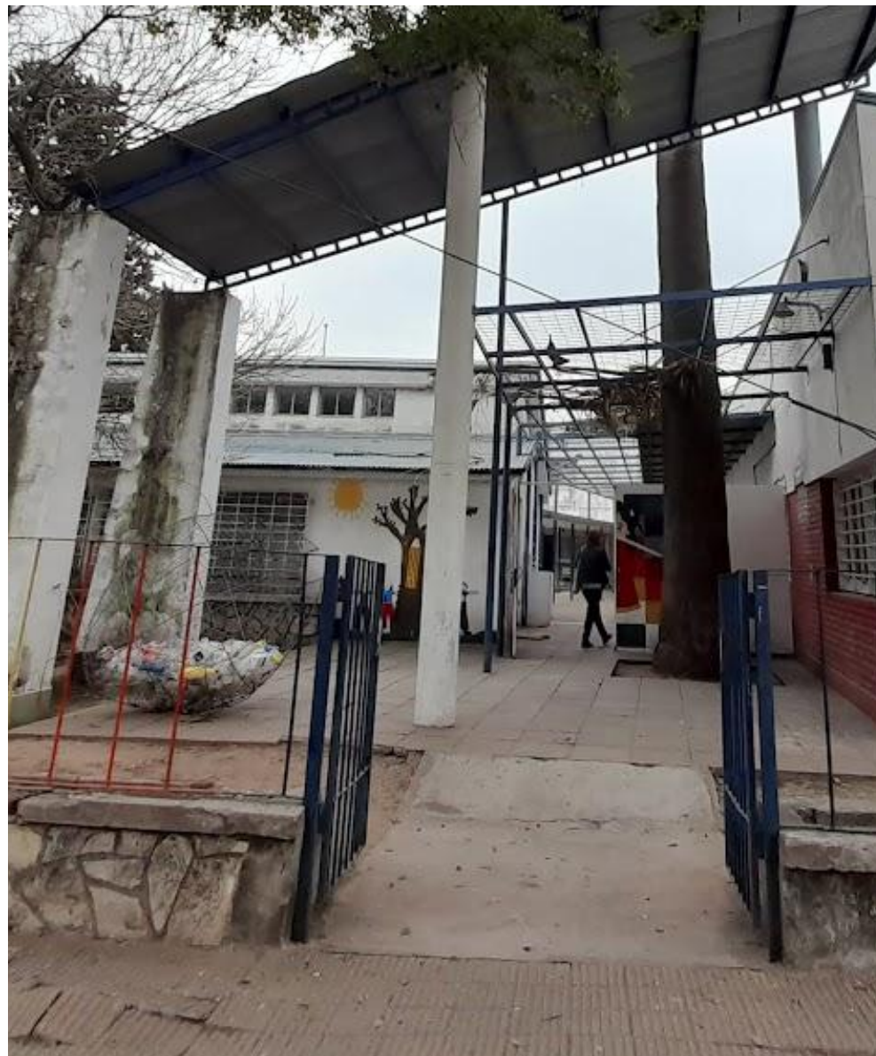
151- Rampa que vincula calle Entre Ríos con el acceso a la Escuela .
