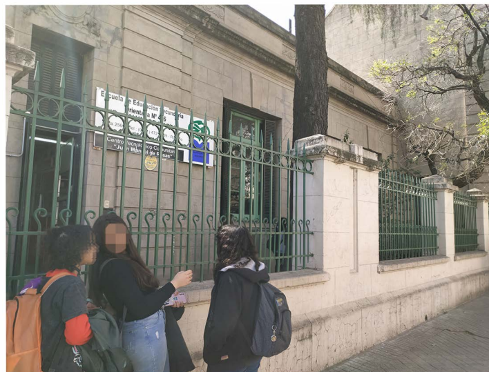
84- Fachada exterior del patio de único acceso a la Escuela por calle Salta.
