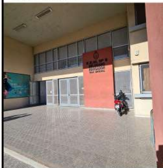
Imagen fachada principal.
