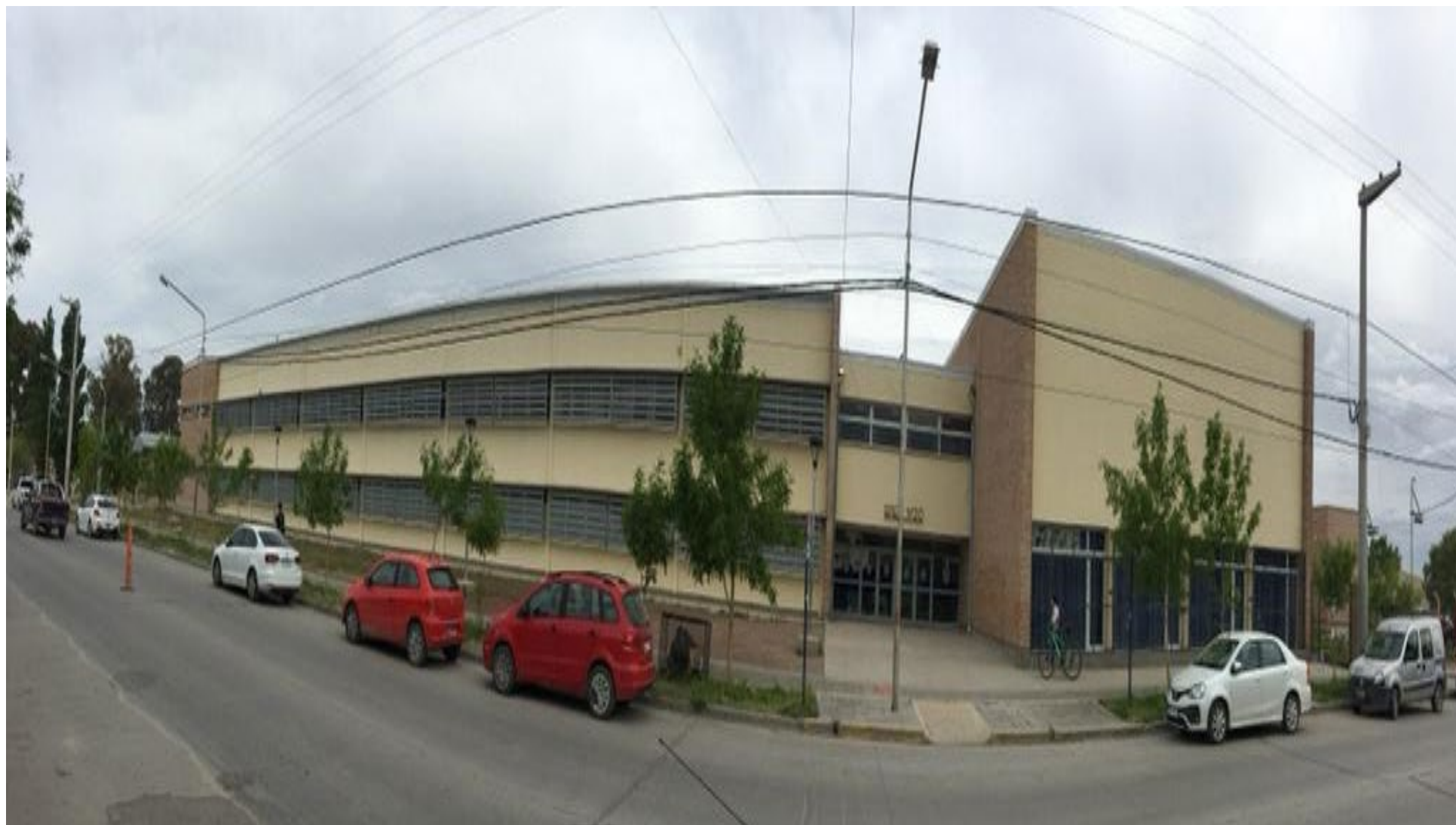
294- Escuela ubicada en el sureste de la ciudad de Neuquén. Edificio inaugurado en 2017.
