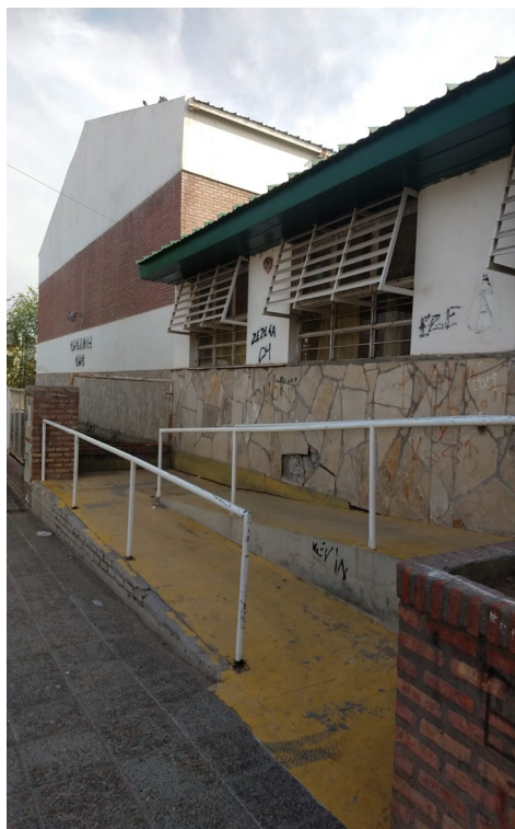
287- Rampa de acceso a la entrada principal.
