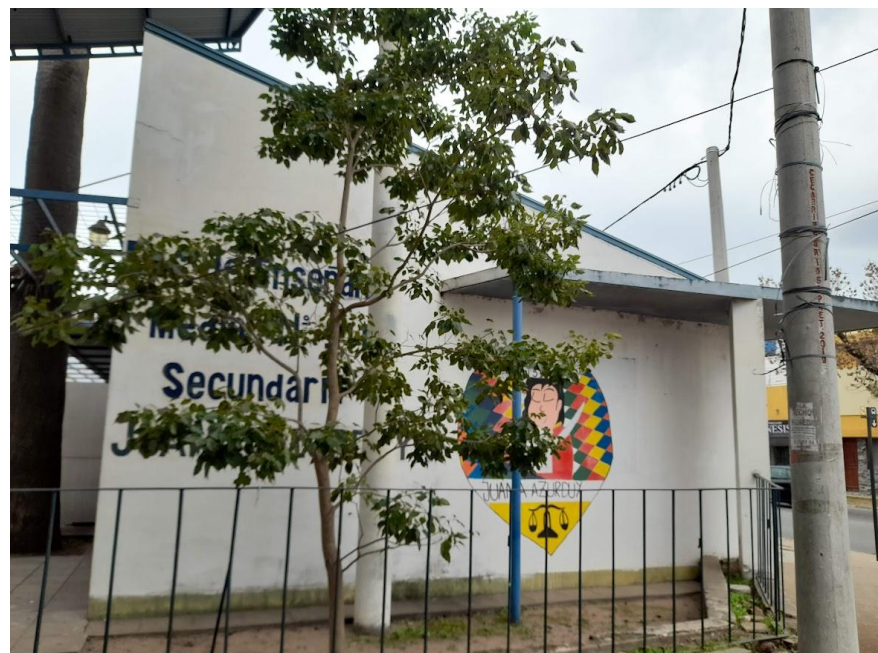
137 y 138 – Vistas parciales de la fachada sobre calle Entre Ríos..
