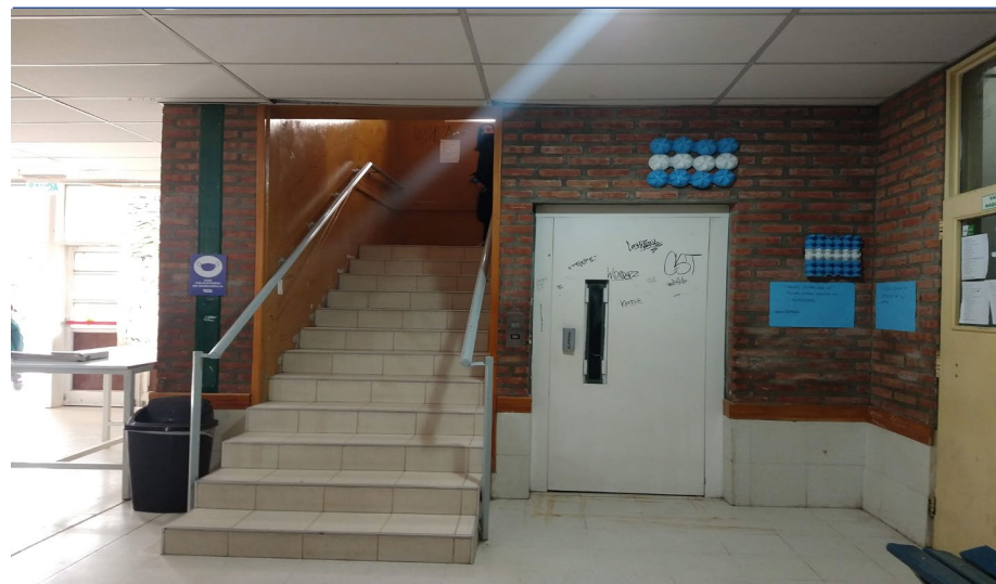
289- Escalera que interrumpe la circulación y puerta de ascensor para acceder al primer piso.
