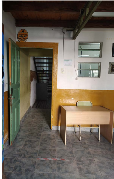
96- Ingreso por pasillo obstaculizado por escalera y recepción.
