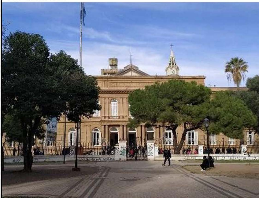
Imagen fachada principal (se observa la torre de la Iglesia por detrás).
