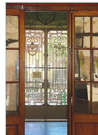
Puertas de fachada. Ver detalles puerta escuela y casa del director
