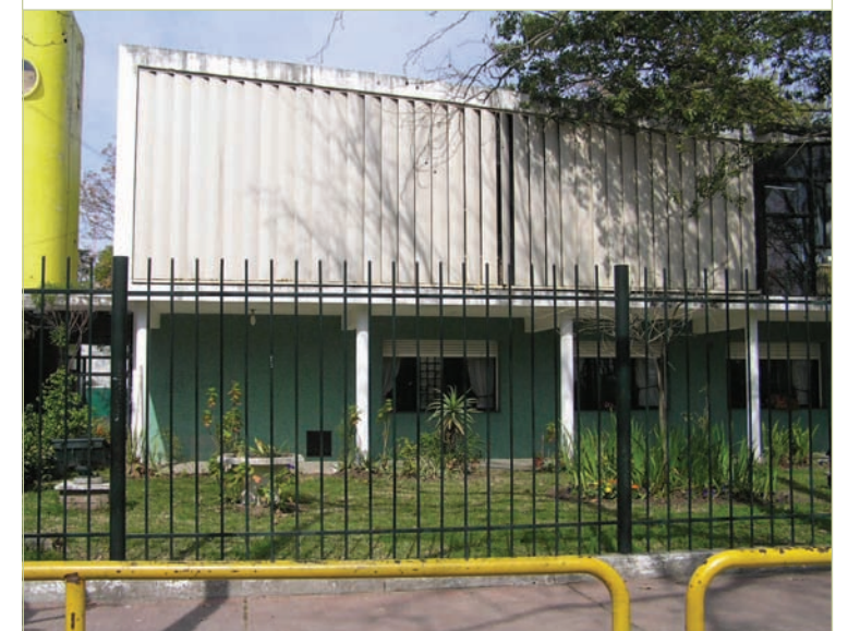
Imagen galería fachada norte
