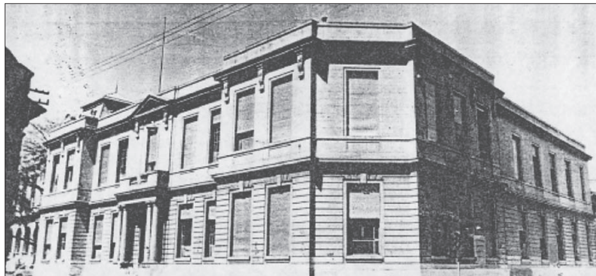
Fachada sobre corte Santa Fe (2da. etapa)
