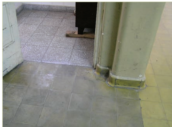
Cambio de piso
