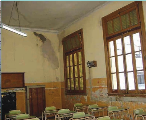
Aulas posteriores que ventilan al patio
