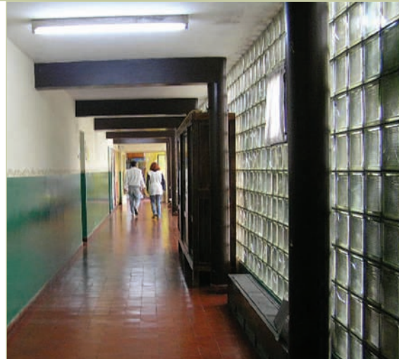
Imagen obra muro ladrillo de vidrio
