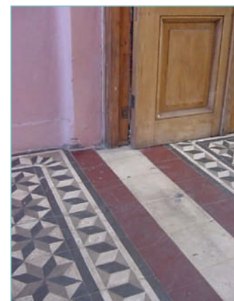
Pisos originales planta alta circulaciones
