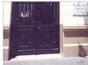
Detalle Zócalo Escuela Goyena
