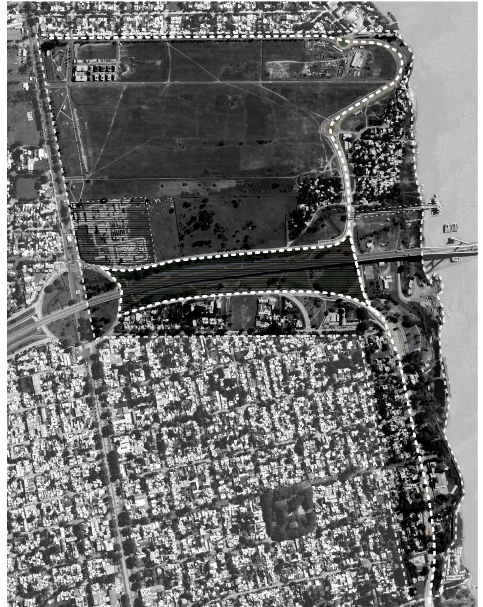
2015 Nueva planta potabilizadora de Aguas Santafesinas 2019 Nuevo parque de la Cabecera y reestructuración de Av. Carraco
