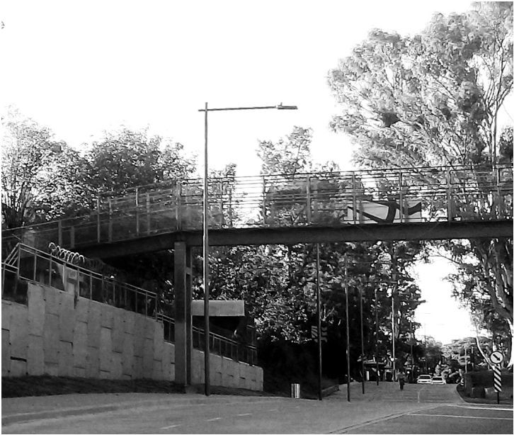
Puente privado Club bajada Scauriza
