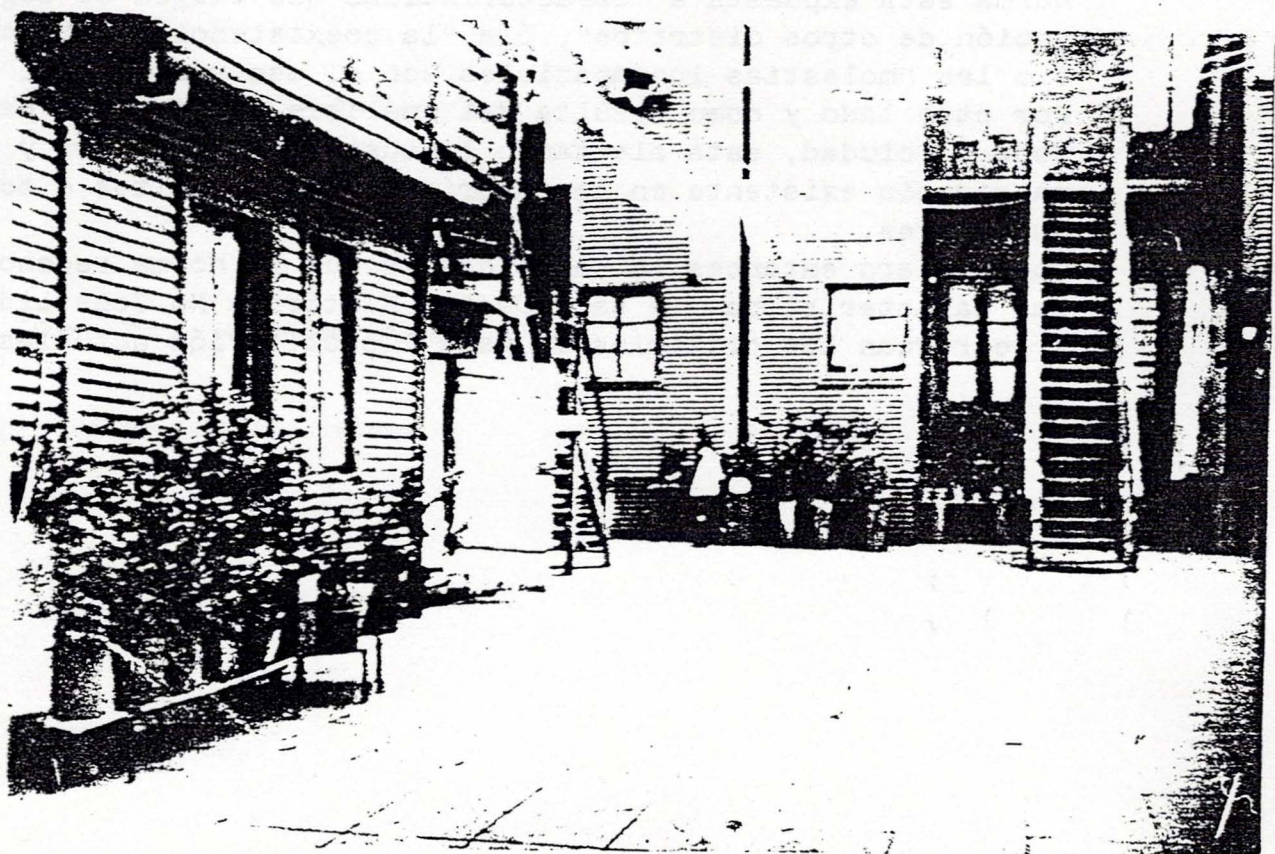
143. Calle Surro y Martín Rodríguez. Interior e Interior. No. 14. Foto General de la Nación.
