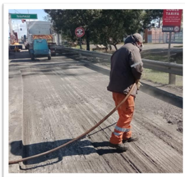
Figura 22. Limpieza de fondo de bache con rifle de aire comprimido
