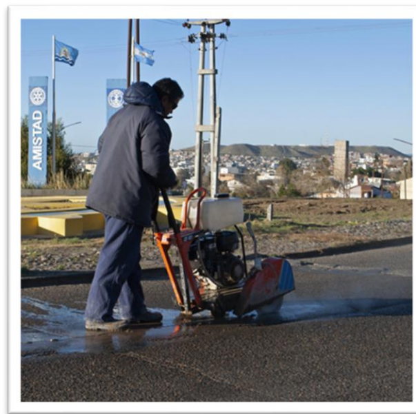
Figura 17. Aserrado de pavimento para delimitación de zona de bache
