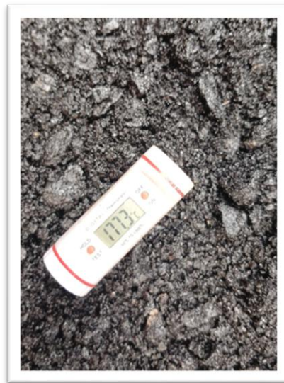
Figura 43. Temperatura de mezcla asfáltica en obra antes de ser corregido el causal.
