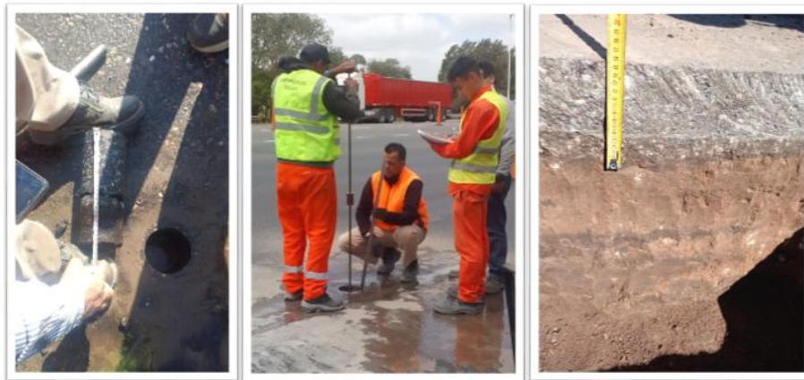
Figura 14. Calados para ensayos DCP y Calicata
