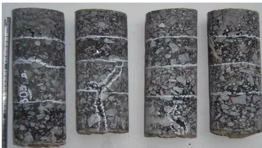
Figura 13. Fotografía de diferentes calados de pavimento flexible
