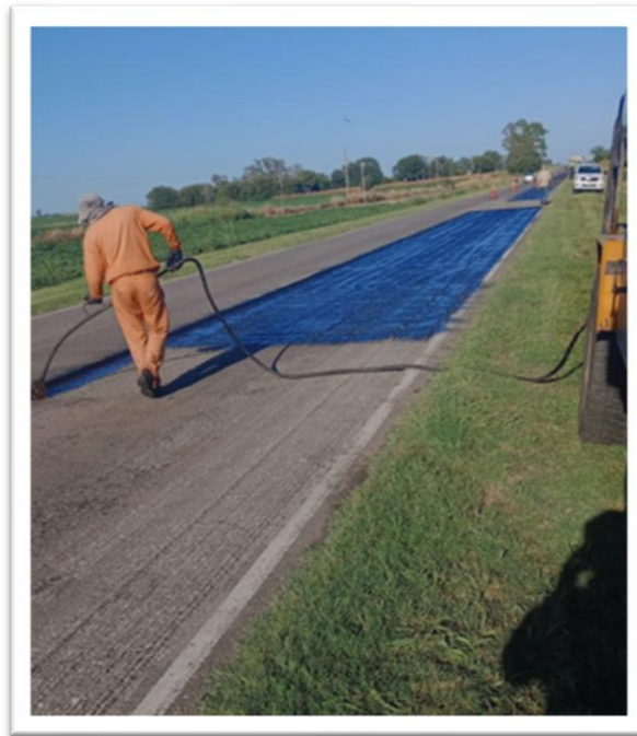
Figura 35. Riego de liga sobre base de concreto
