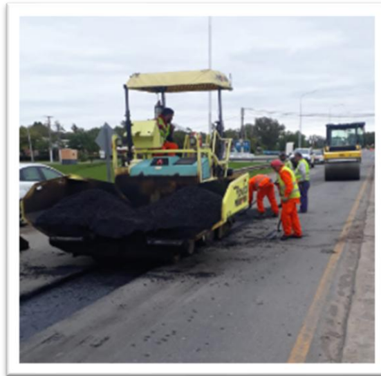
Figura 24. Terminadora de asfalto trabajando en un bache de 1 metro
