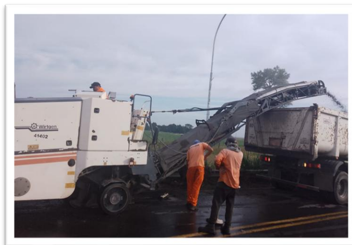
Figura 33. Fresado con maquina fresadora de 1 metro de ancho de tambor
