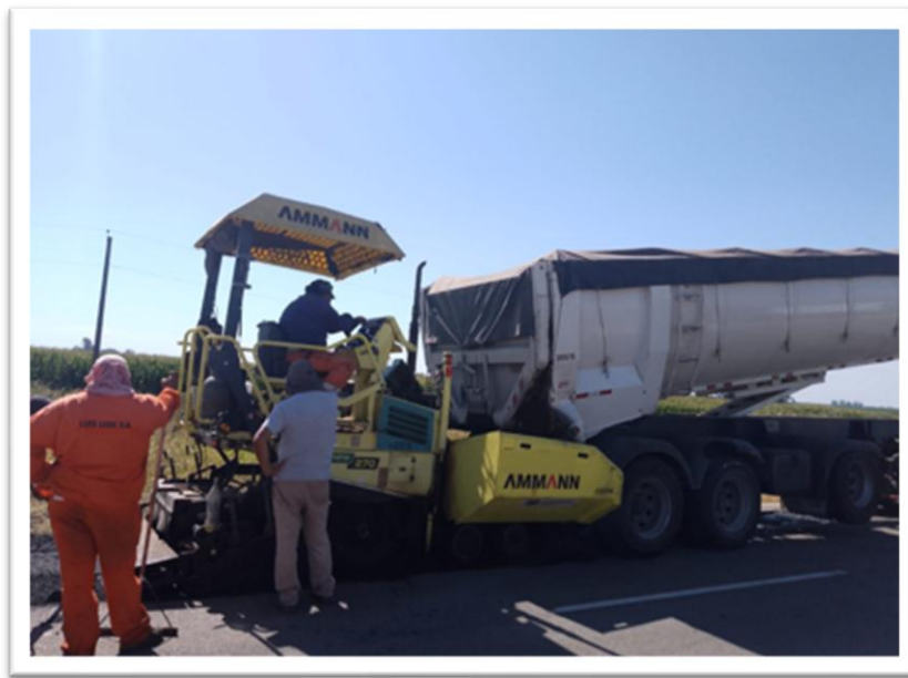
Figura 36. Batea descargando mezcla asfáltica en tolva de terminadora
