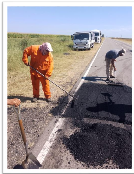
Figura 39. Rastrillado de mezcla y juntas
