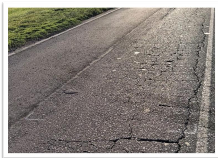
Figura 32. Bache delimitado sobre huella externa izquierda
