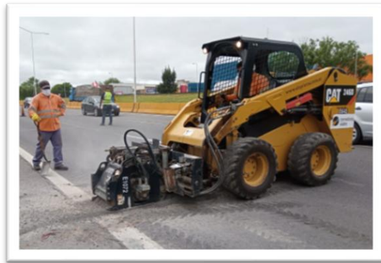
Figura 20. Fresado de pavimento con minicargadora con implemento de fresa de 40 cm de ancho de tambor
