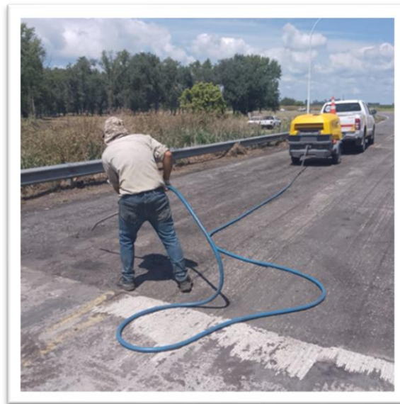
Figura 34. Limpieza de superficie con compresor de tiro y lanza, palas y cepillos.
