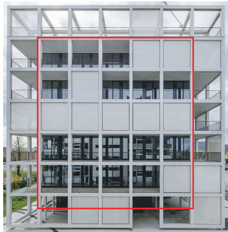
El edificio consta de un núcleo dominado por vidrio dentro de una estructura de hormigón flotante.
