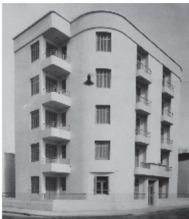
Edificio Macera. Wheelwright 1309 y Entre Ríos (Rosario). Arqs. Tito y José Micheletti, 1936c. (Imagen: Archivo Micheletti)
