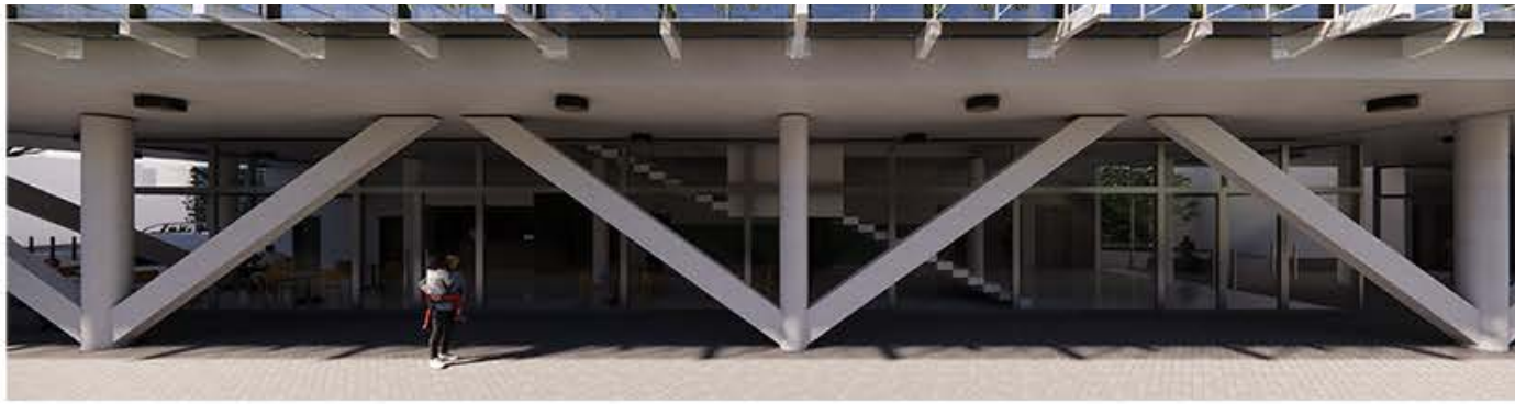
Vista planta baja, columnas en V.
