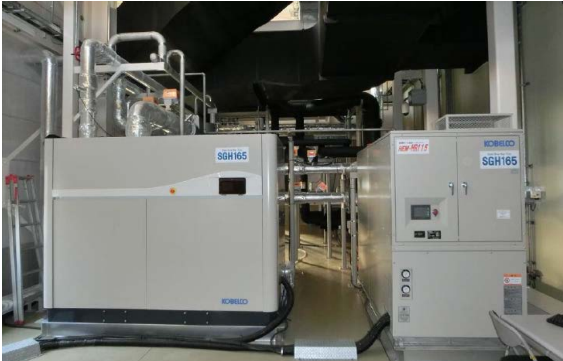
Figura 2. 48 SGH 165 unidad compresora de vapor (izquierda), bomba de calor (derecha)
