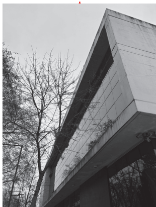
FACHADA SUR Abertura retraída
