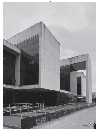
FACHADA ESTE Desplazamiento volúmenes/ pañós ciegos
