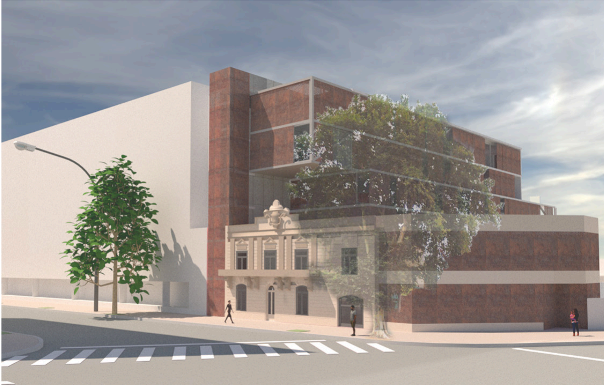
Imagen exterior del proyecto. Fuente: autoría propia
