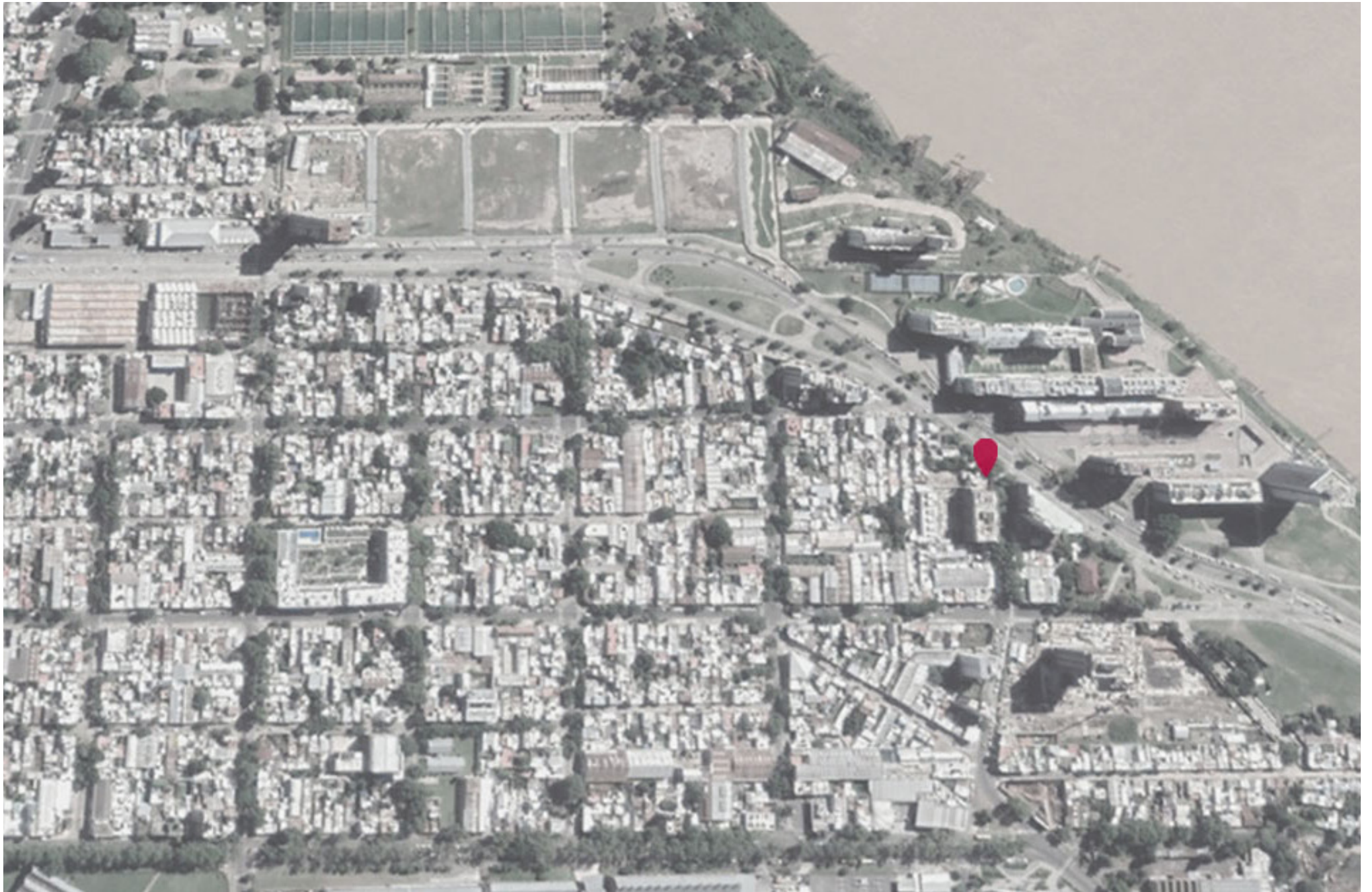
Foto aerea. Aproximación all sitio de intervención. Fuente: https://www.google.com/earth/
