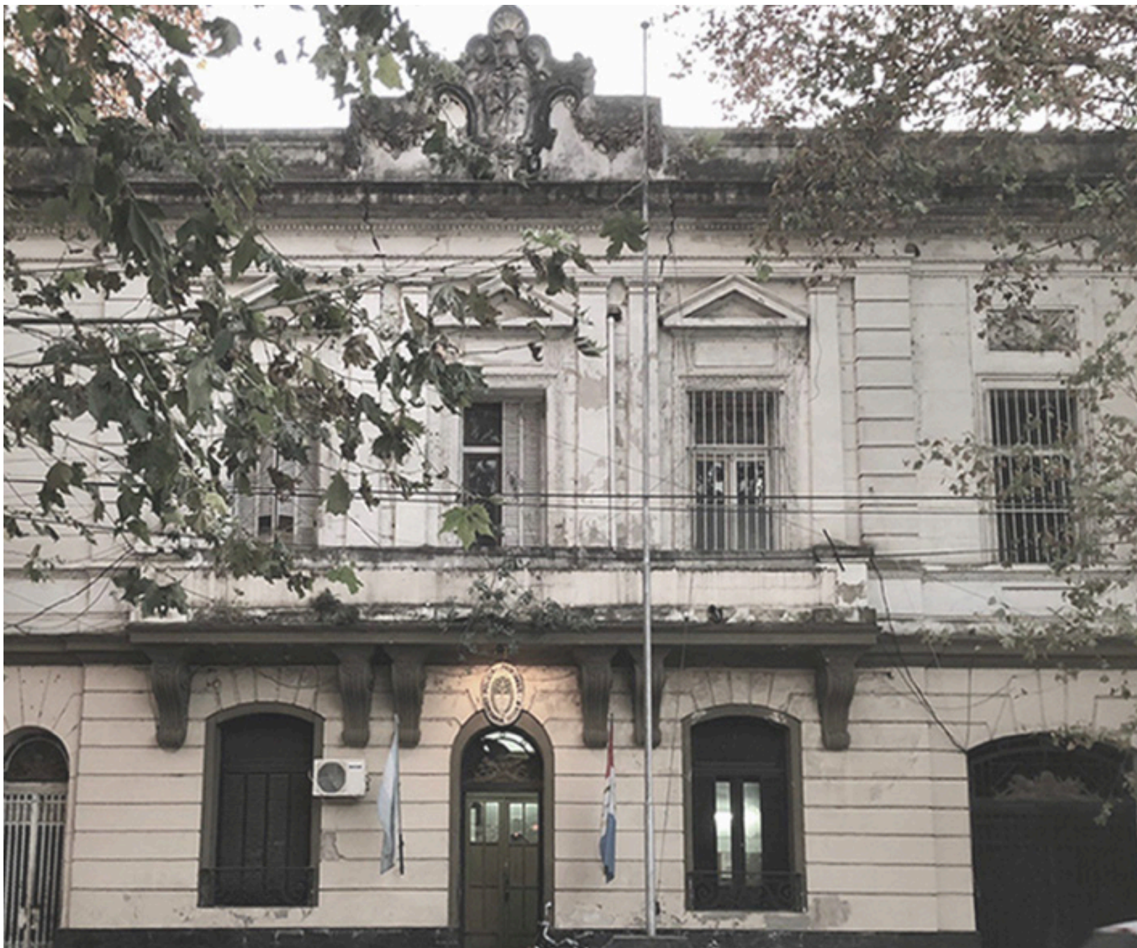
Fachada actual del edificio existente. Fuente: autoría propia.
